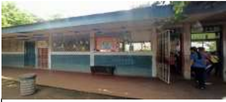
Imagen N° 2 Pabellón del primer
