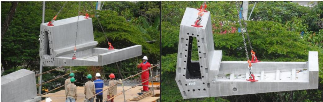
fotografía 7-1 Sección de Sección de dovela Prefabricada Ref (<http://camilo-toro.squarespace.com/puente-peatonal-eafit/n7napp3384fnreq30ik4abi0dbuiq9>).
