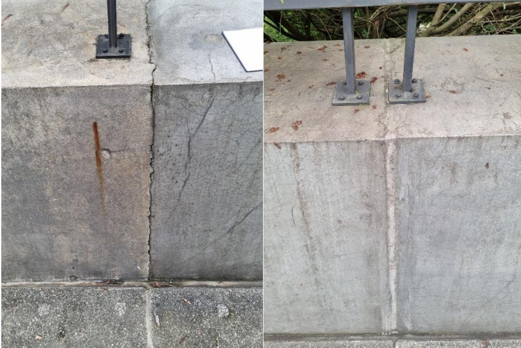
*fotografía 7-4 Izquierda junta diafragma- Derecha junta de Dovelas.*
