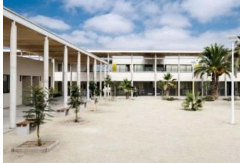
FIGURA 14: Vista Panorámica Interna del Liceo Jorge Alessandri
