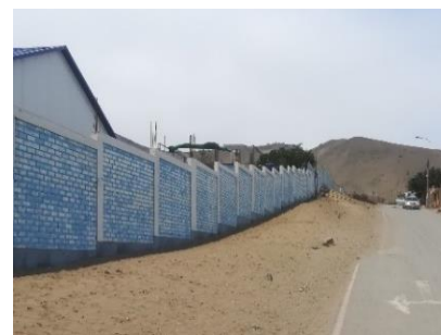
FIGURA 31: Fachada Noroeste I.E. N°8187
