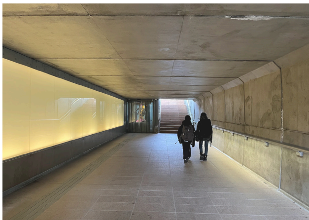
Foto viser dimensjonene i undergangen, samt plasseringen av utgangen og heisen. Plassering av trapp skaper en flaskehalseffekt, noe som vil øke trengselen ved høy gjennomstrømning av mennesker.
