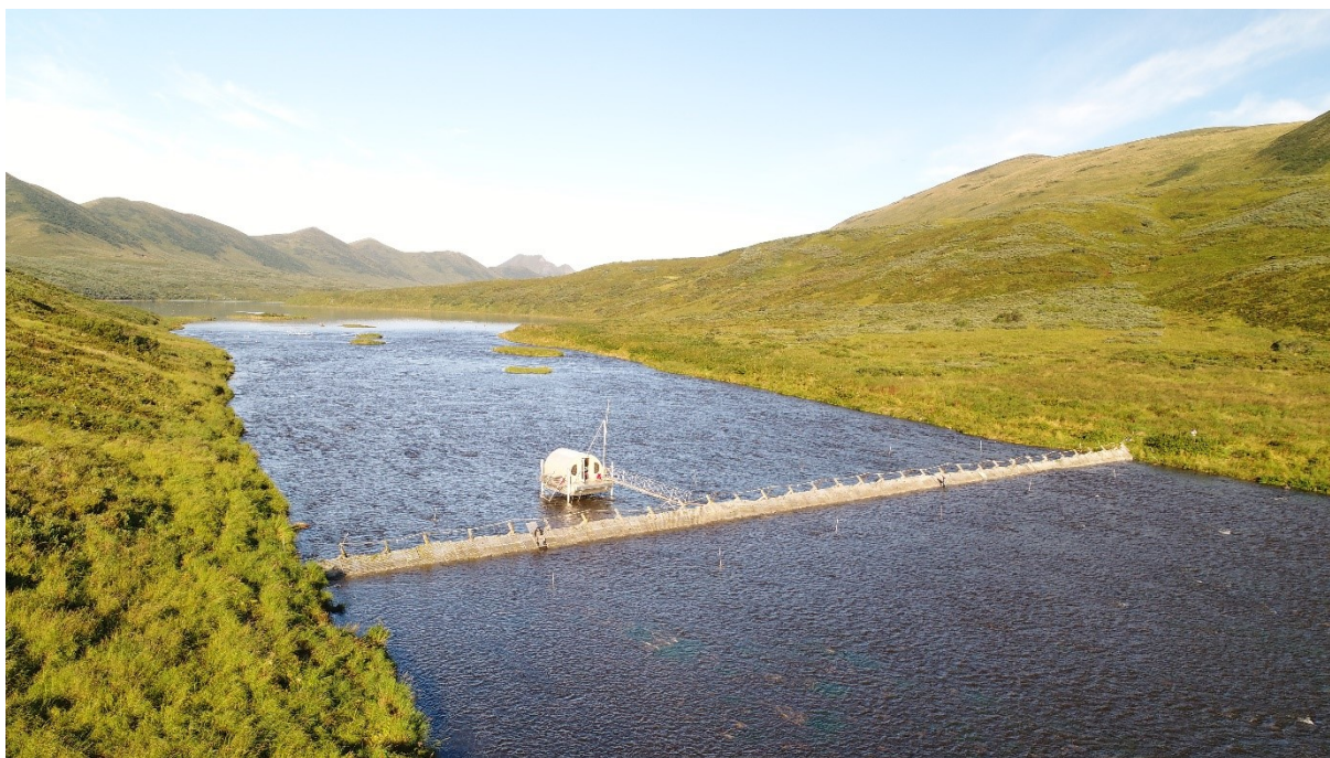
Kuva 6. Kalojen laskenta-aita Karluk-joella Kodiakin saarella Alaskassa. Kuva: Brad Fuerst, Alaska Department of Fish and Game.
