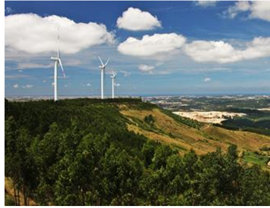
Figura 3.8 – Parque Eólico situado em Torres Vedras, Portugal [25].
