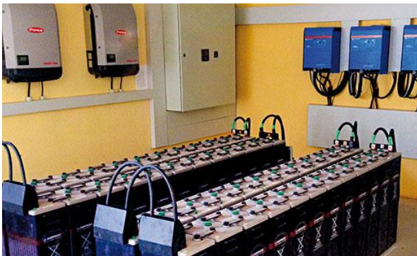
Figura 3.3 – Sistema autoconsumo com bateria [20].
