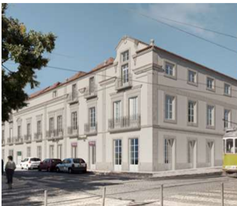
Figura 2.5 – Edifício do Palácio Condes de Murça, Lisboa, Portugal (LiderA., 2022)
