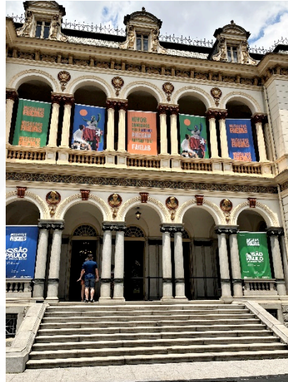
Figura 2: Fachada do Museu das Favelas/SP. Foto A. 21 jan. 2023.
