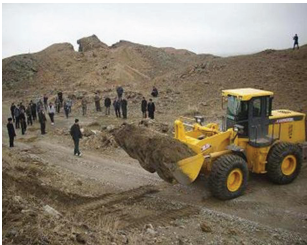
Рис. 11. Местное население помогает устанавливать ограждения вокруг Кислотного озера
