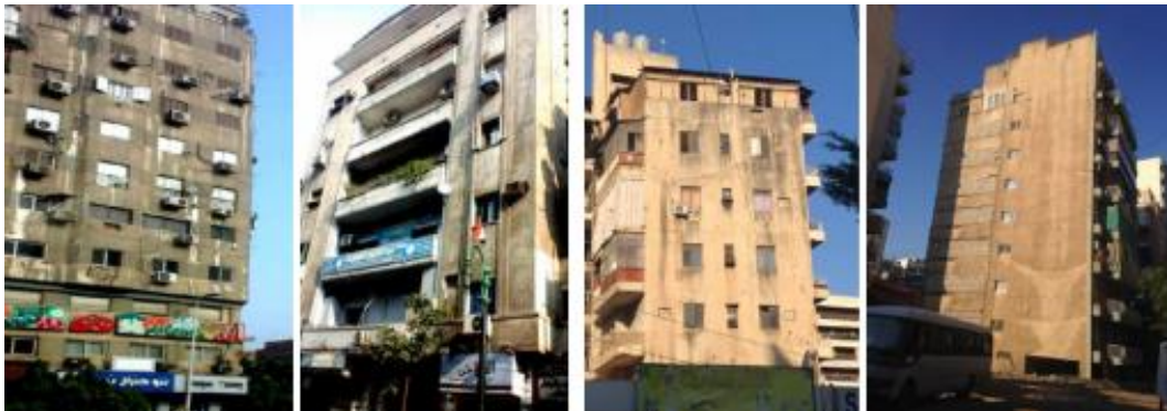
(a) Ejemplos de fachadas de edificios en El Cairo, (b) Ejemplos de fachadas de edificios en Beirut, Líbano
