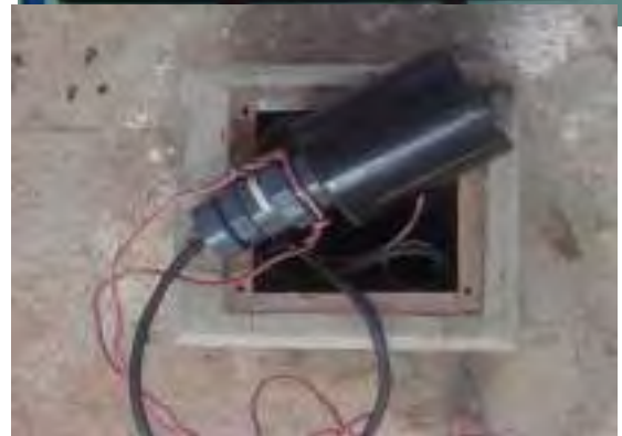
MEDIDOR DE NIVEL DE TANQUE CISTERNA RUMICOLCA ULTRASONICO
