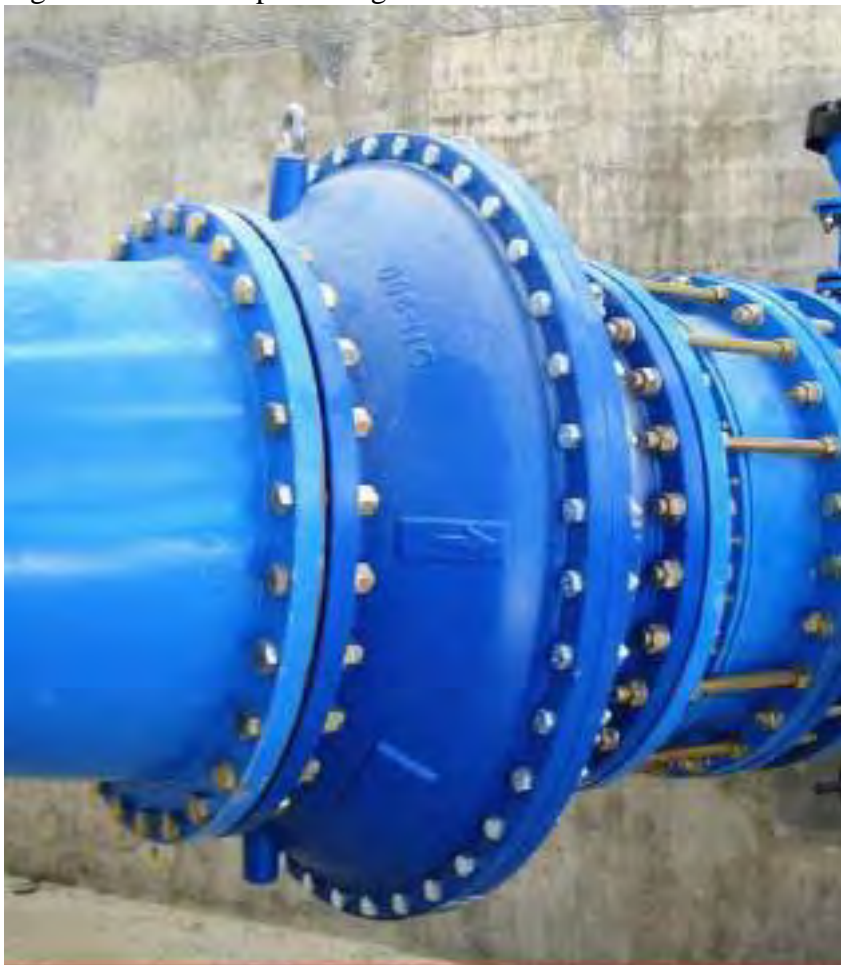
Figura 37 : Válvula antirretorno concéntrica mistral ross para proteger la estación de bombeo de golpes de ariete: al actuar se cierra inmediatamente mediante un tapón elástico que evita el reflujos de agua y la formación de ondas de choque. (Rec. de https://www.lagua.es/ , 2022)
