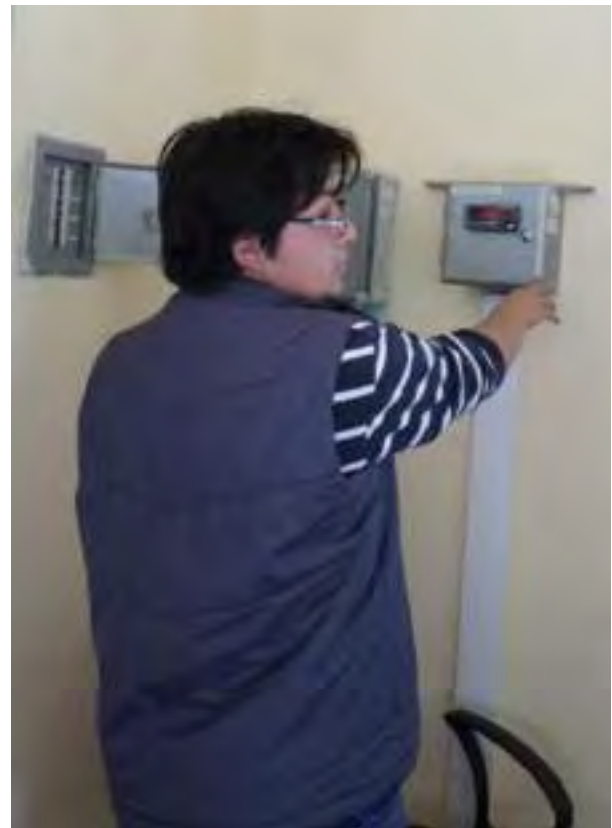
VERIFICACIÓN Y COMPROBACIÓN DE CAUDALIMETRO ELECTROMAGNETICO VS CAUDALIMETRO ULTRASÓNICO PT58
