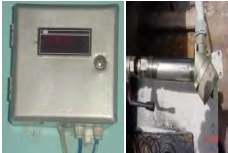
MANÓMETRO – PARA MEDICIÓN DE PRESIÓN A SALIDA DE ÁRBOL DE DESCARGA LÍNEA DE IMPULSIÓN
