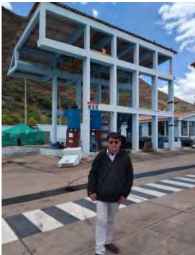
VISTA PANORÁMICA ESTACIÓN DE BOMBEO 02 RUMICOLCA
