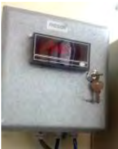
PRESOSTATO ELECTRÓNICO
