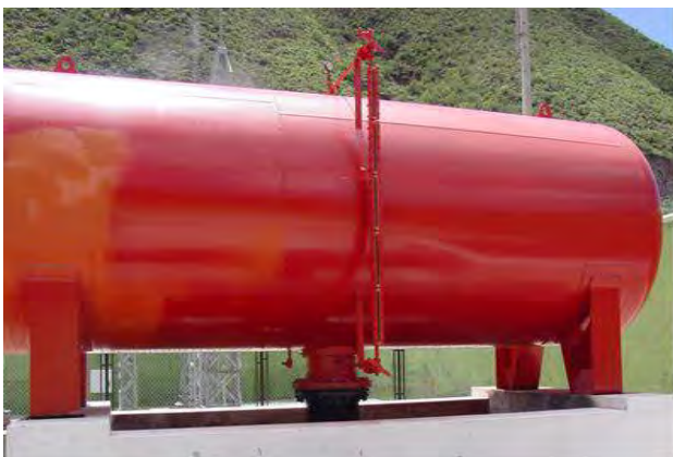
FOTO N° 14 : SISTEMA DE PROTECCIÓN HIDRÁULICO PARA GOLPE DE ARIETE EN TUBERÍA DE IMPULSIÓN - ARBOL DE DESCARGA ESTACIÓN DE BOMBEO 02
