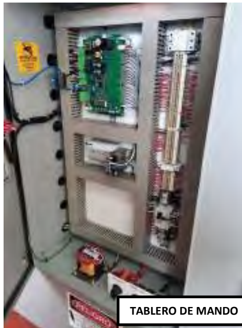
FOTO N° 19 : SALAS DE MANDOS, TRANSFORMADOR Y TABLEROS DE CONTROL DE LAS ELECTRO BOMBAS
