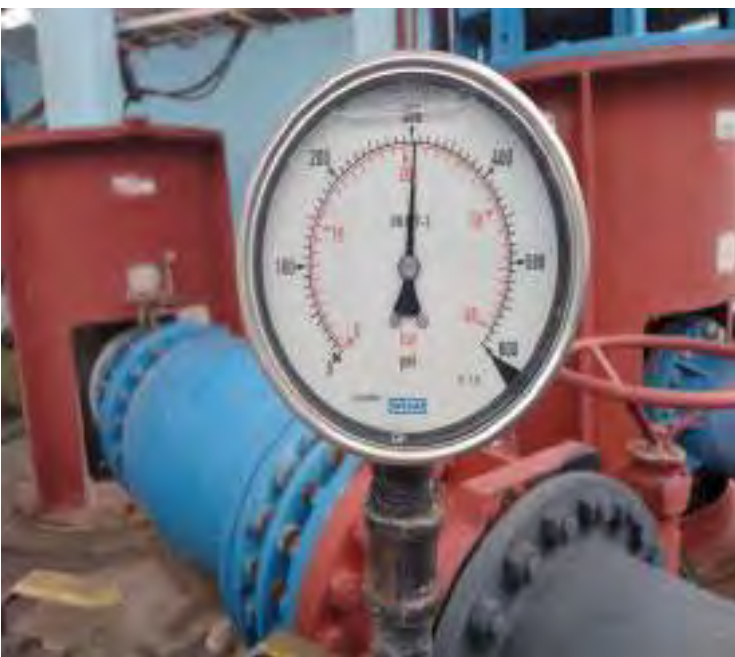
PRESIÓN DE ARRANQUE ESTACIÓN DE BOMBEO 03 COLLANA
