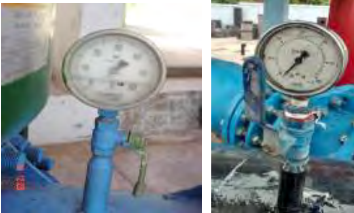
MANÓMETRO – PARA MEDICIÓN DE PRESIÓN A SALIDA DE ÁRBOL DE DESCARGA LÍNEA DE IMPULSIÓN
