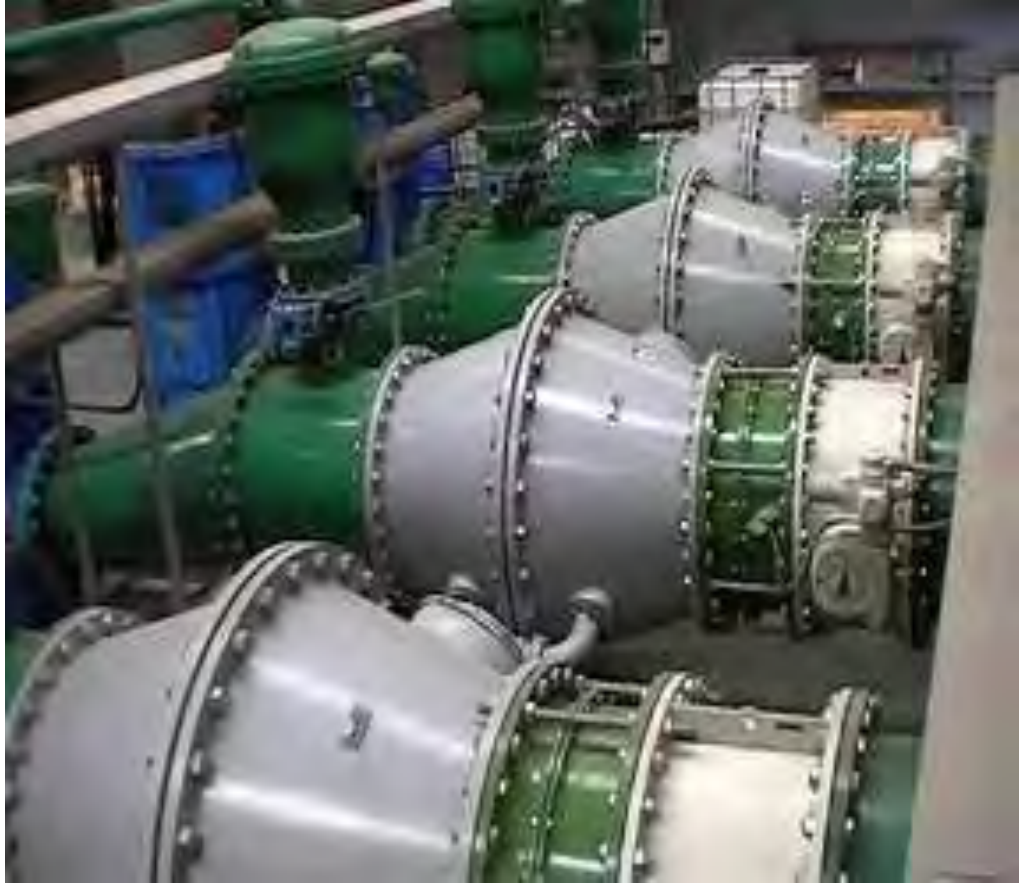
Figura 38 : Válvulas antiretorno multidisco “Casa Ibapol Polanco”; protegen las estaciones de bombeo de los golpes de ariete. Cuando funciona, algunos discos se cierran, impidiendo el retorno del agua y la formación de ondas de choque. (Rec. de https://www.lagua.es/ , 2022)
