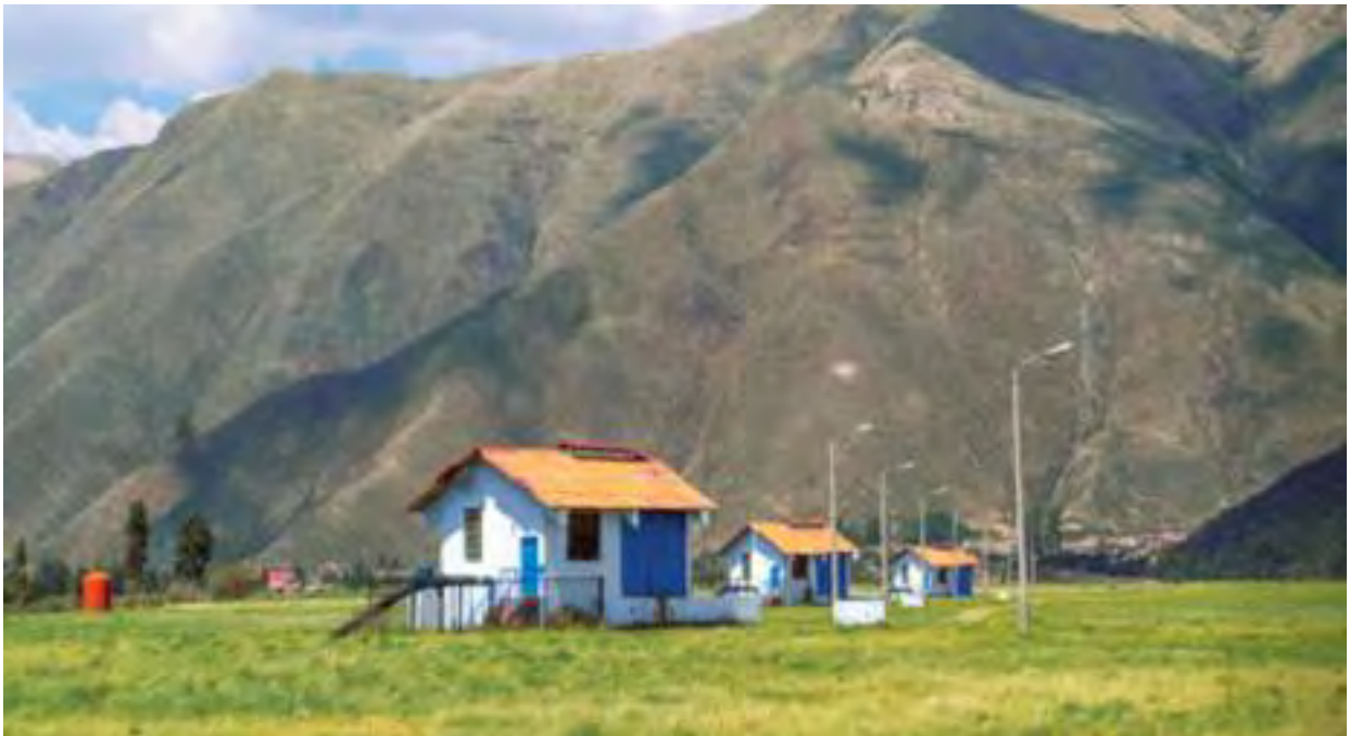
FOTO N° 3 : CAPTACIÓN DE AGUAS SUB-SUPERFICIALES MEDIANTE 04 CASSETAS DE BOMBEO
