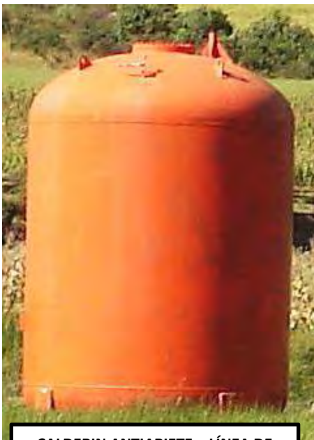
CALDERIN ANTIARIETE – LÍNEA DE IMPULSIÓN PINIPAMPA 1000 LITROS
