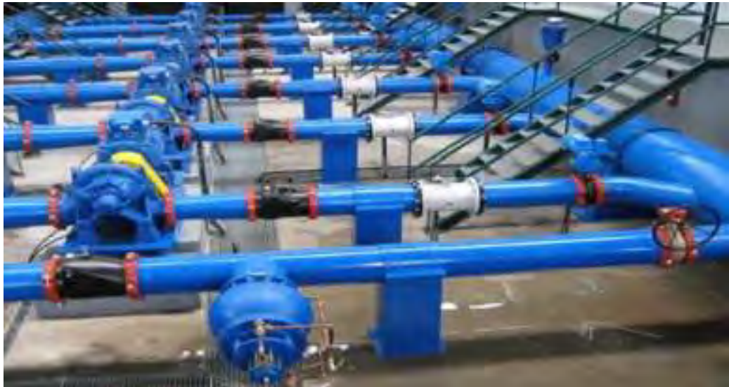
Figura 27 : Vista General de una estación de bombeo con válvula de alivio ross de cuerpo en ángulo de la tubería de impulsión(Rec. de https://www.lagua.es , 2022)
