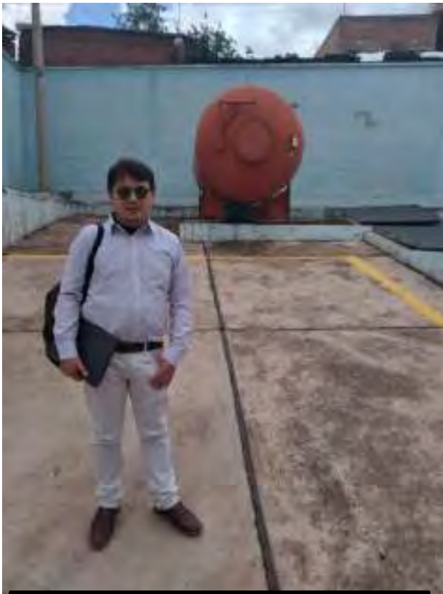
CALDERIN DE 15'000 ( QUINCE MIL LITROS ) – ESTACIÓN DE BOMBEO 03 COLLANA
