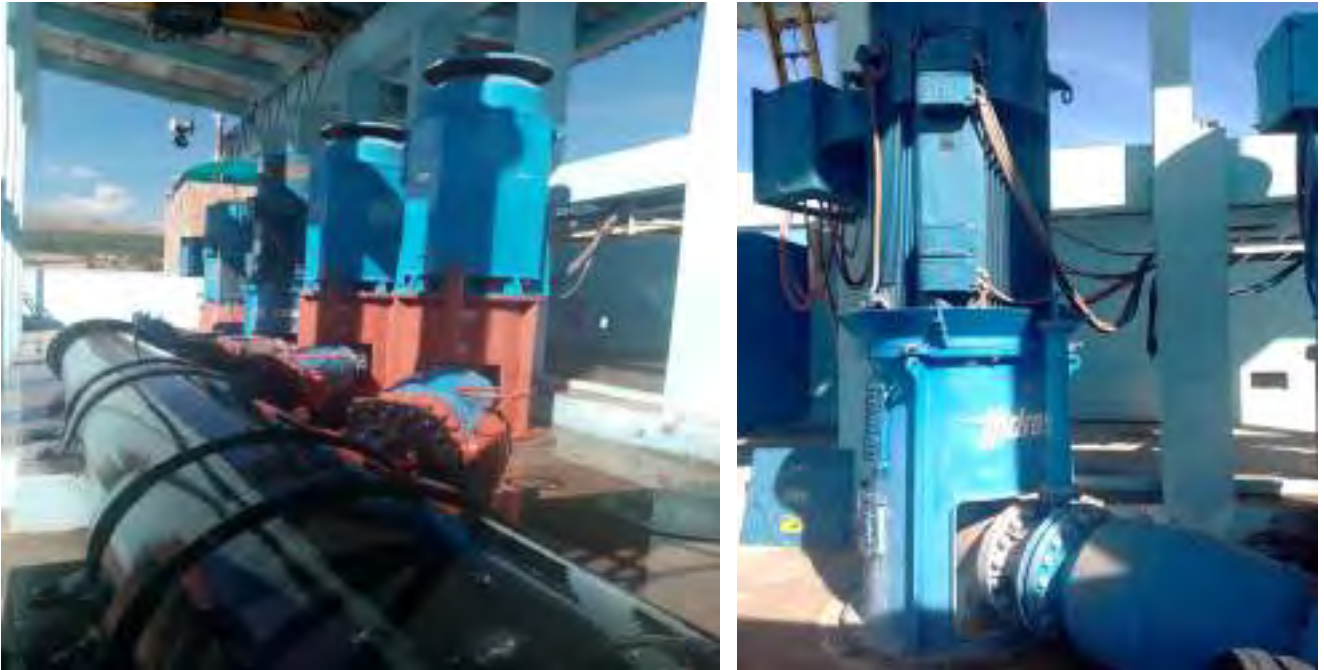
FOTO N° 27 : SISTEMA DE PROTECCIÓN HIDRÁULICA PARA GOLPE DE ARIETE EN TUBERÍA DE IMPULSIÓN - ÁRBOL DE DESCARGA ESTACIÓN DE BOMBEO 02
