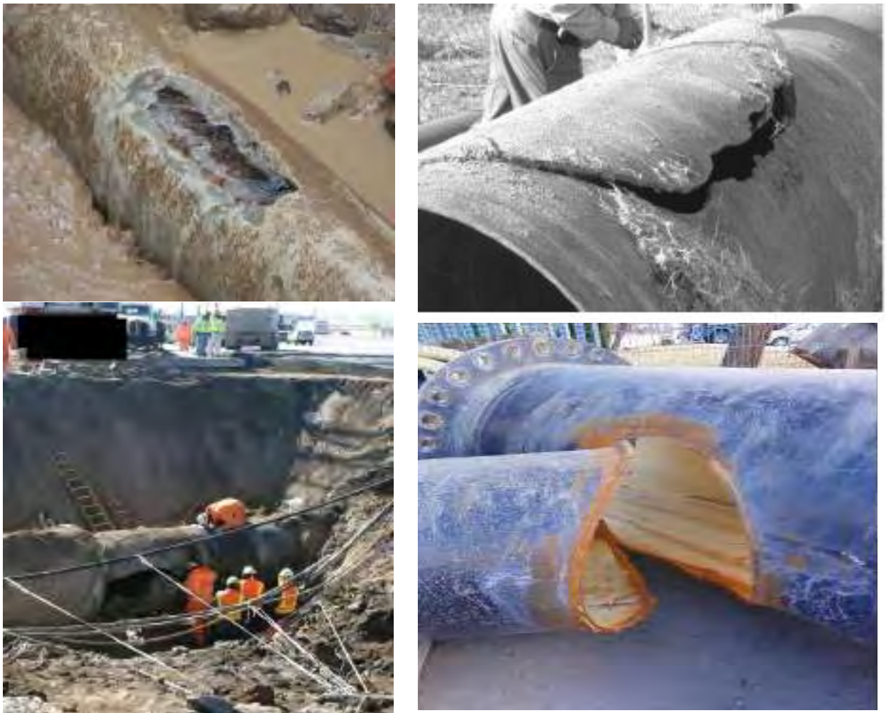
Figura 23 : Colapso de Tuberías producido por Sobrepresiones (Gandarilla I., 2017)
