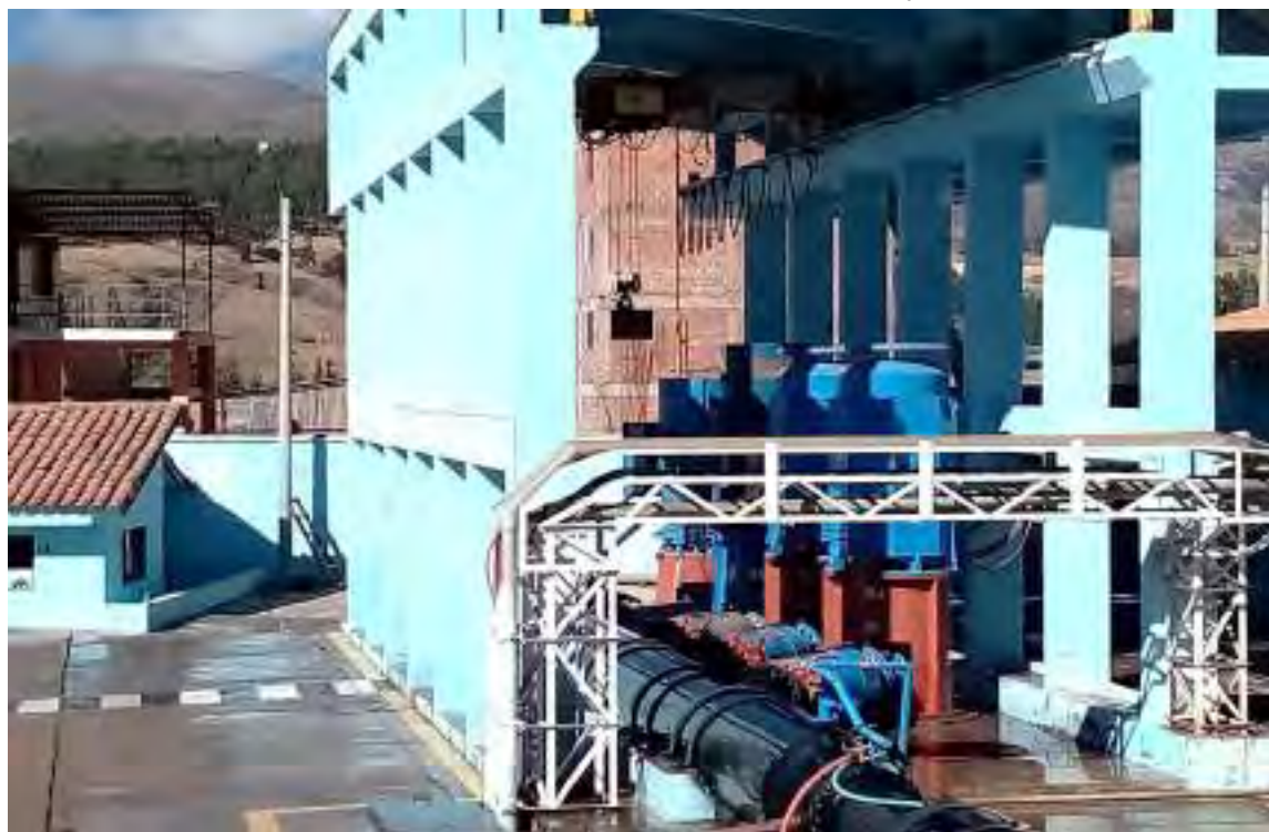
FOTO N° 25 : SALA DE BOMBAS BOMBAS INSTALADAS HIDROSTAL, ESTACIÓN DE BOMBEO 03
