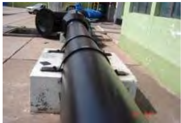
FOTO N° 14 : SISTEMA DE PROTECCIÓN HIDRÁULICO PARA GOLPE DE ARIETE EN TUBERÍA DE IMPULSIÓN - ARBOL DE DESCARGA ESTACIÓN DE BOMBEO 02
