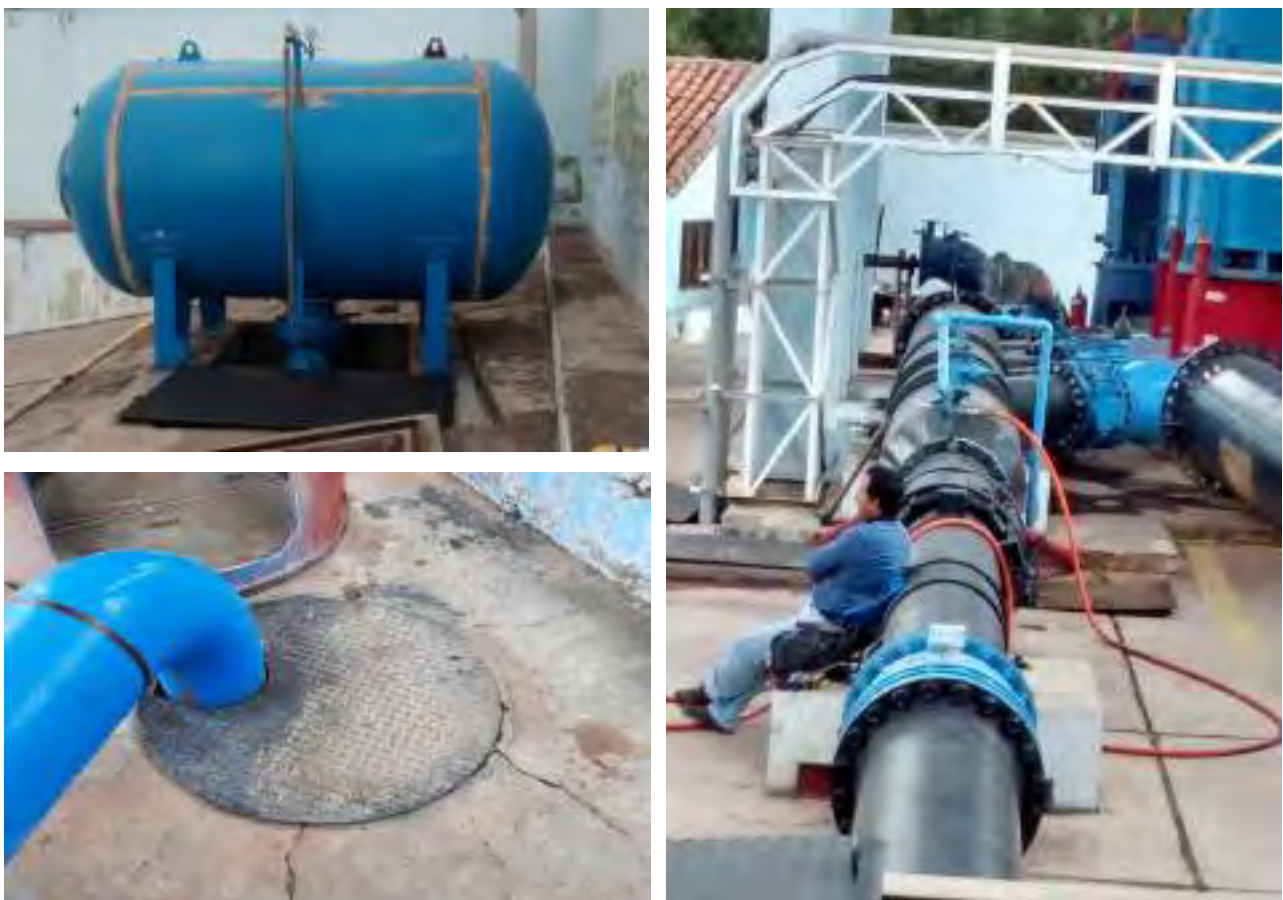
FOTO N° 27 : SISTEMA DE PROTECCIÓN HIDRÁULICA PARA GOLPE DE ARIETE EN TUBERÍA DE IMPULSIÓN - ÁRBOL DE DESCARGA ESTACIÓN DE BOMBEO 02
