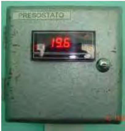
MANÓMETRO – PARA MEDICIÓN DE PRESIÓN A SALIDA DE ÁRBOL DE DESCARGA LÍNEA DE IMPULSIÓN
