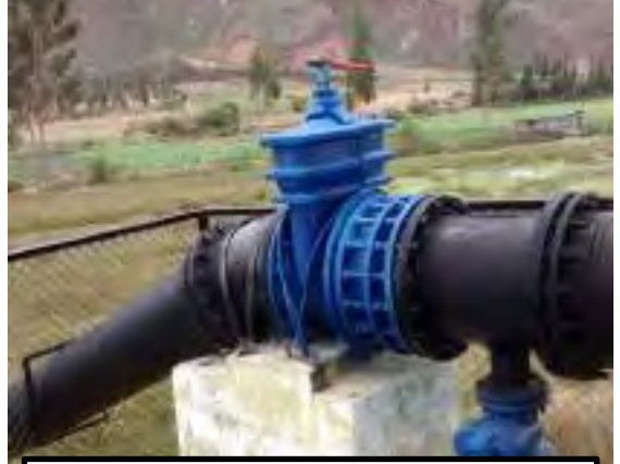
VÁLVULA MARIPOSA DE CONTROL - A L A SALIDA ÁRBOL DE DESCARGA
