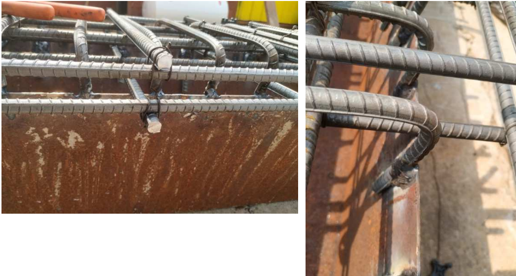
Figura 51: Fotos de pernos soldados a la chapa
