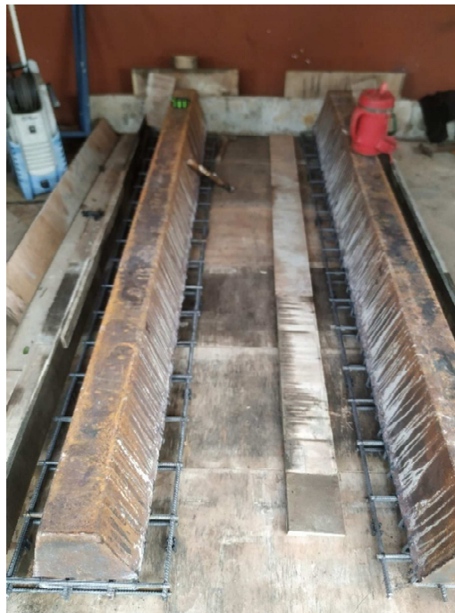
Figura 59: Vista en proceso de elaboración de las formas de encofrado sobre piso
