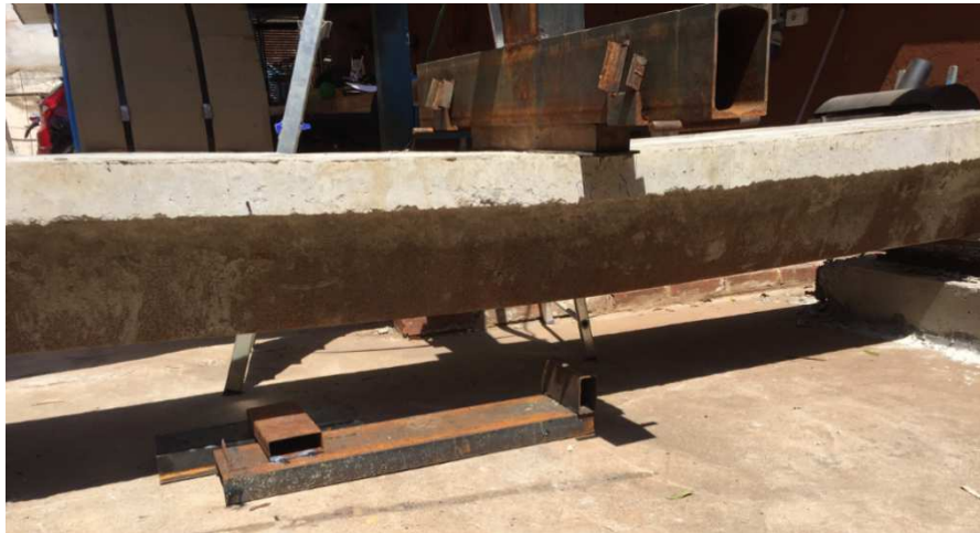
Figura 105: Vista de la viga 3 en el momento de máxima deformación
