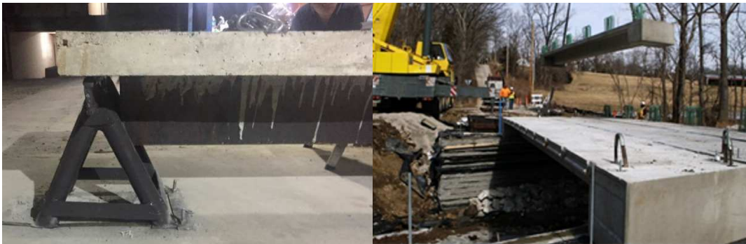
Figura 38: Comparación de dos forma de apoyo, Foto izq. caballete de apoyo. Foto der. bloque extremo de apoyo, Con-Struct™ Prefabricated Bridge System, (2017)
