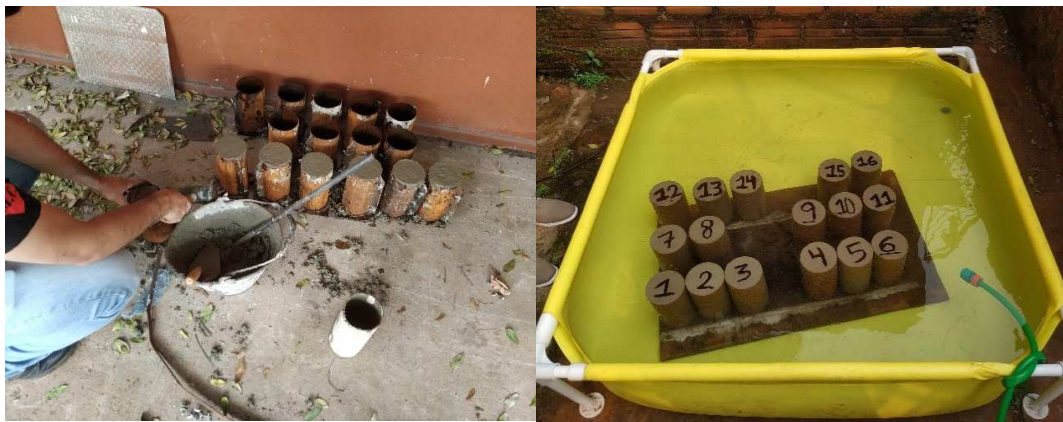
Figura 57: Moldeado de los cuerpos para rotura para control de la resistencia del hormigón
