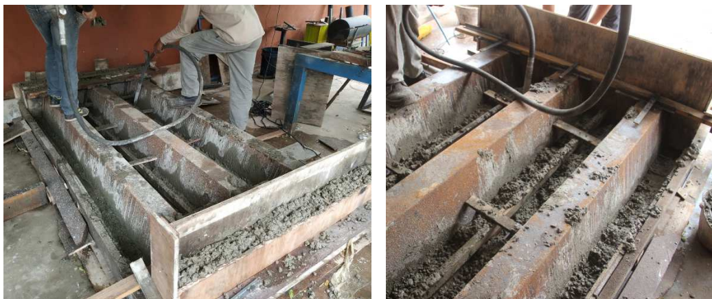
Figura 60: Vista de hormigonado de la mesa de compresión
