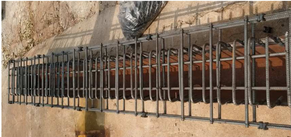
Figura 54: Disposición terminada de la armadura en viga típica
