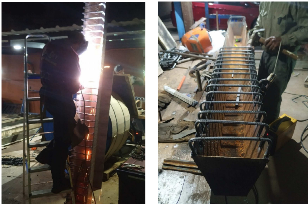
Figura 55: Preparación y ejecución de la soldadura de los pernos de corte
