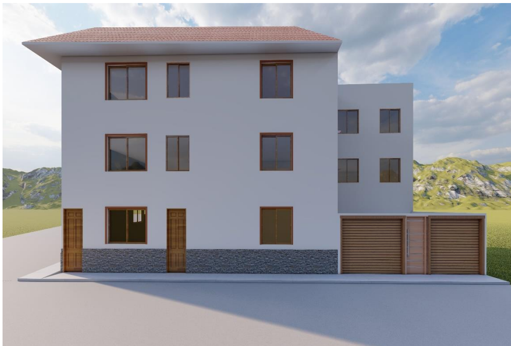
Figura 15. Fachada lado Oeste
