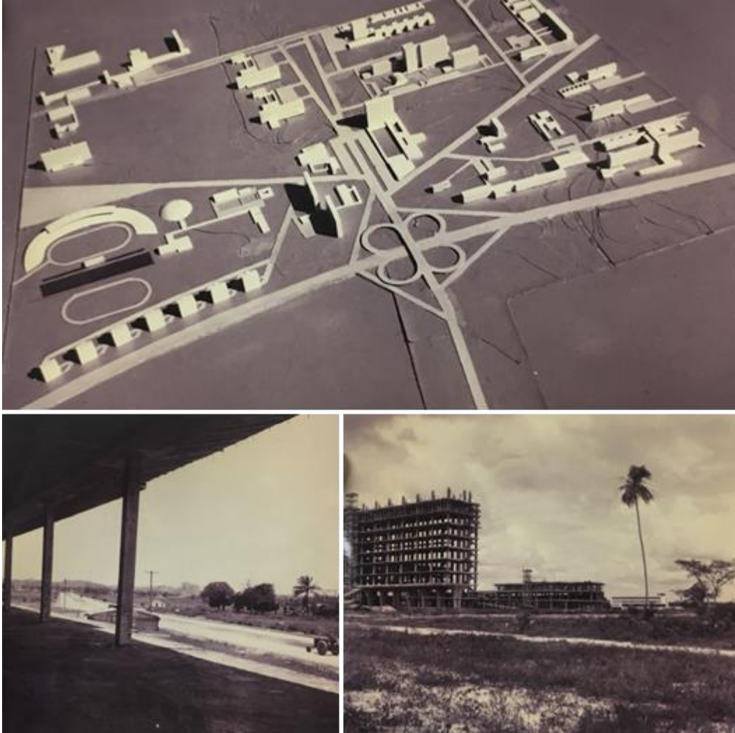
Figura 1. Maquete do campus Joaquim Amazonas da UFPE e edificações em construção.
