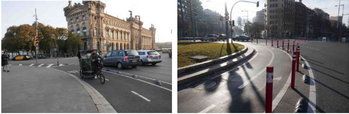
図8-5 交差点にラウンドアバウトが設置され、中心部近くが自転車レーンとなっている。(撮影日時:図8-4と同じ)
