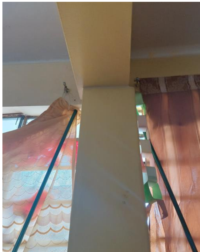
Figura 36. Irregularidad por vigas no alineadas con las columnas ubicada en el aula de 6° grado del segundo piso. Fuente: Propia.
