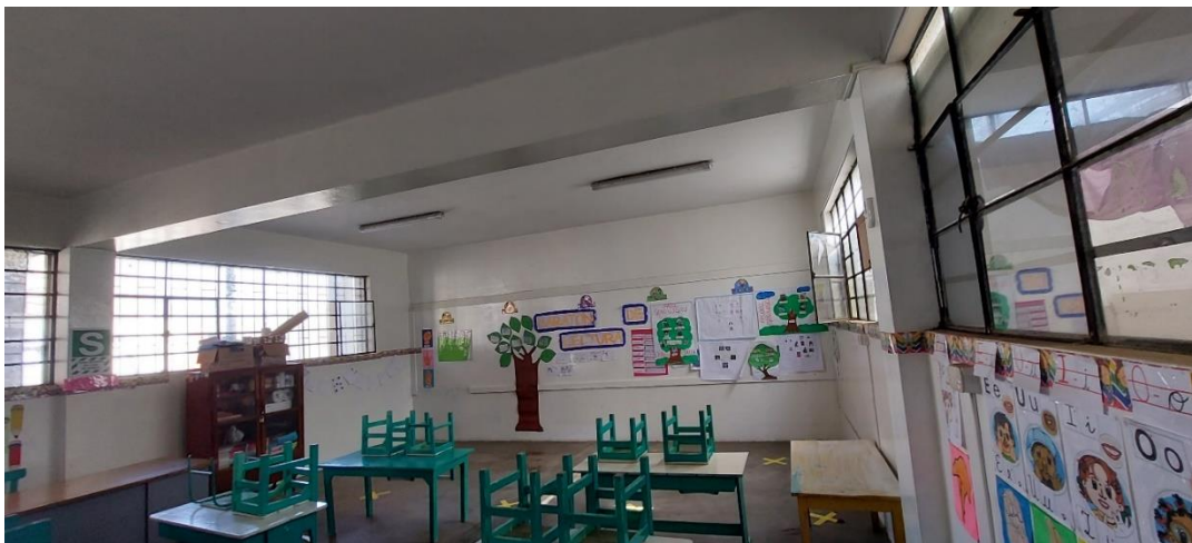
Figura 23. Se puede observar que la cobertura del primer piso es un techo de losa aligerada. Fuente: Propia.
