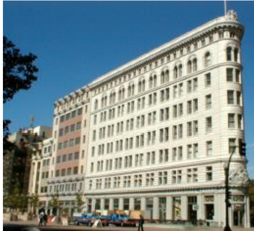
Figura 11. Irregularidad en planta según los sistemas no paralelos y son los que tienen forma de triángulo de acuerdo a estudios previos. Adaptado de "Rapid visual screening of buildings for potential seismic hazards: a handbook", (FEMA, 2015)
