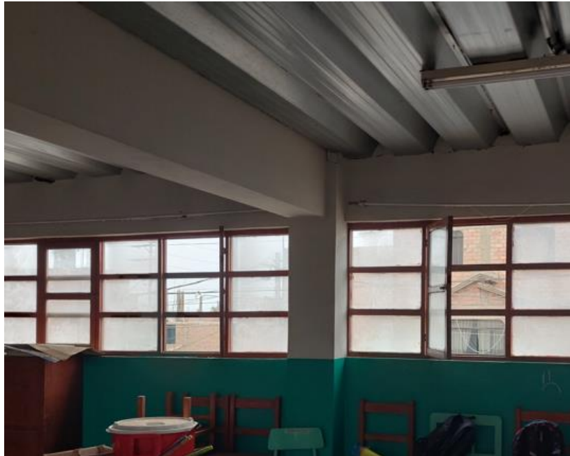
Figura 36. Irregularidad por vigas no alineadas con las columnas ubicada en el aula de 6° grado del segundo piso. Fuente: Propia.
