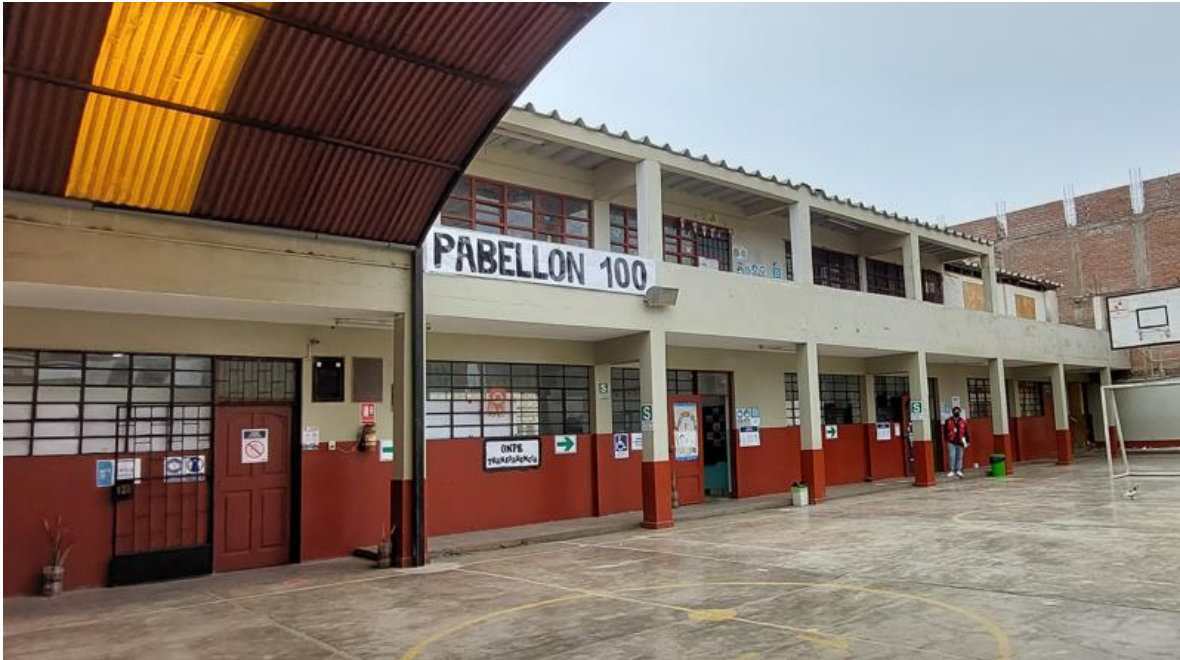
Figura 20. Fotografía del pabellón evaluado, en donde se puede observar el primer y segundo piso. Fuente: Propia.
