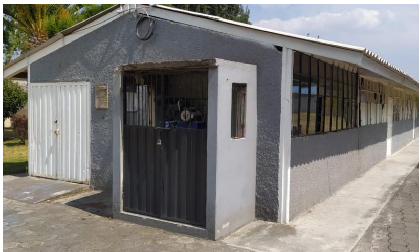
Ilustración 2-3: Estado inicial del Laboratorio
