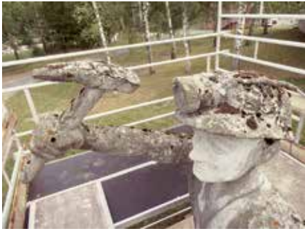
Zustand vor der Sanierung – Risse im Beton und Moosbewuchs haben dem Bergmannsdenkmal arg zugesetzt.
