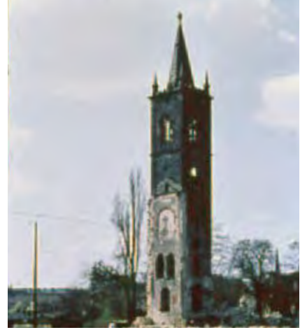
Abb. 44: In der Nacht vom 13. zum 14. Februar 1945 wurde die Kirche schwer zerstört, beim letzten Angriff am 17. April stürzte ein Turm ein, Aufnahme um 1950.
