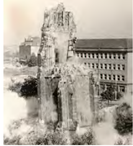
Abb. 52: Sprengung der Anglikanischen Kirche vom Bahndamm aus gesehen
