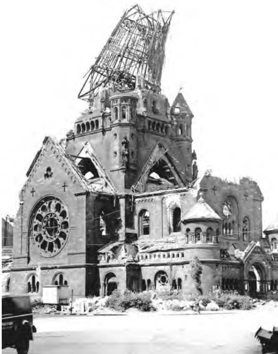
Abb. 122: Die Kirchenruine vor der Sprengung
