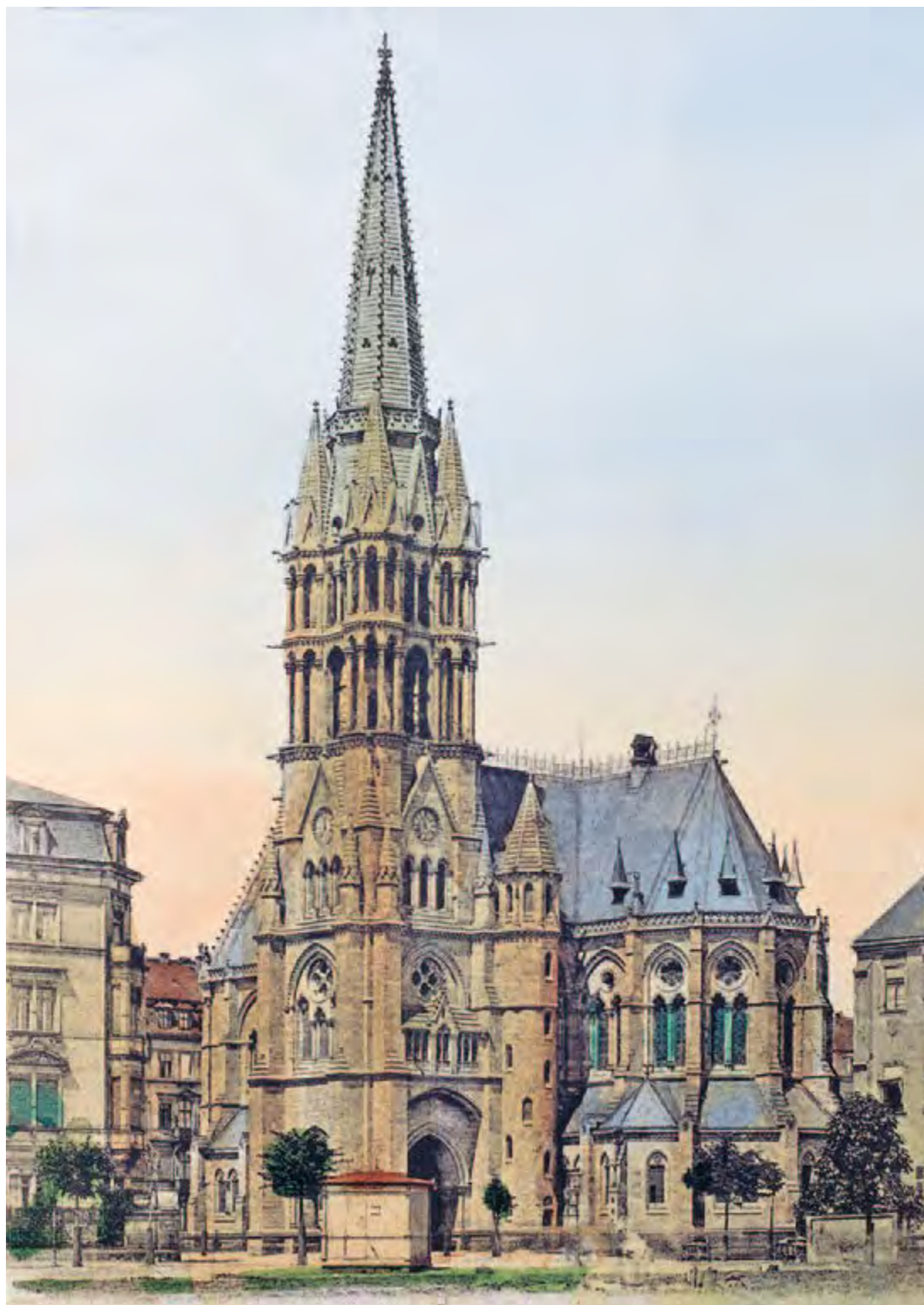
Abb. 55: Die Johanneskirche an der Pillnitzer Straße/Ecke Güntzstraße um 1900
