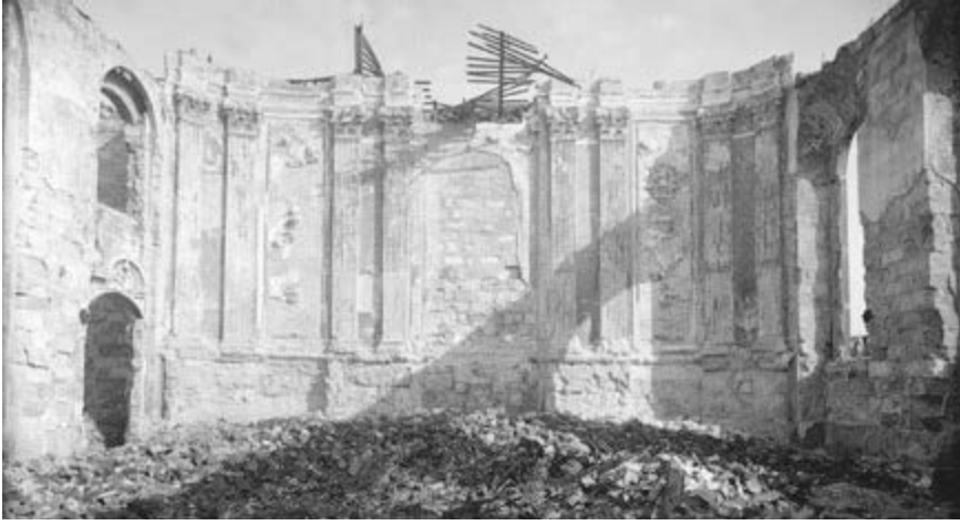
Abb. 186: Altarwand der Kapelle nach der Zerstörung
