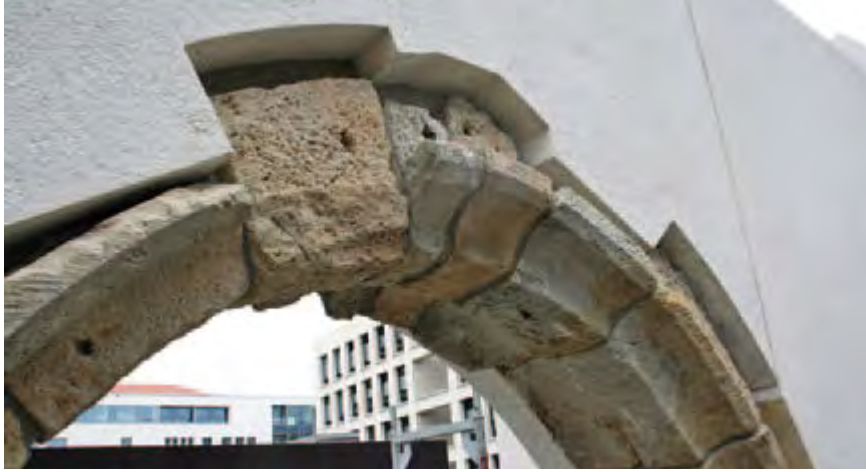
Abb. 17: Originale Gewölbesteine sind in die neuen Betonmauern eingesetzt.
