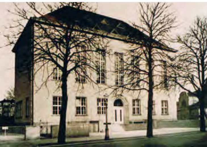
Abb. 156: Das Gemeindehaus der Andreaskirche an der Canalettostraße, 1945 zerstört
