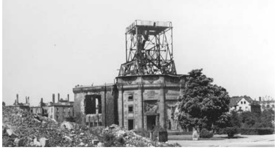
Abb. 173: Kirchenruine mit dem ausgelühten Stahldachstuhl
