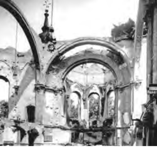
Abb. 105: Kircheninneres vor der Beräumung
