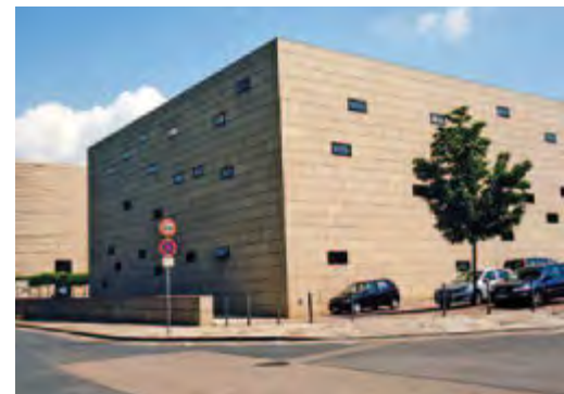
Abb. 38: Eine neue Synagoge steht seit 1998 nahe des alten Standortes.
