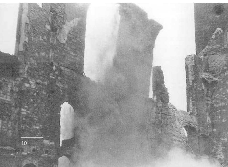
Abb. 16: Abbrucharbeiten im Dezember 1962
