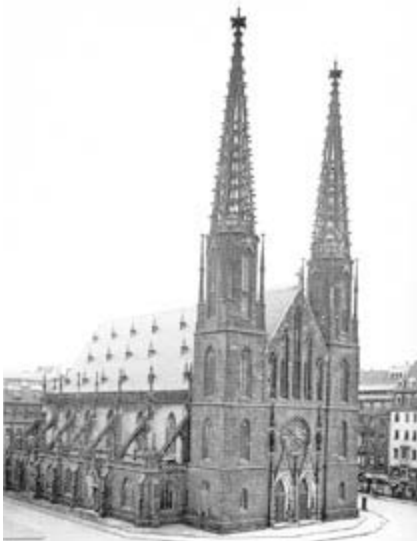
Abb. 10: Die Sophienkirche nach dem Umbau durch Christian Friedrich Arnold 1868
