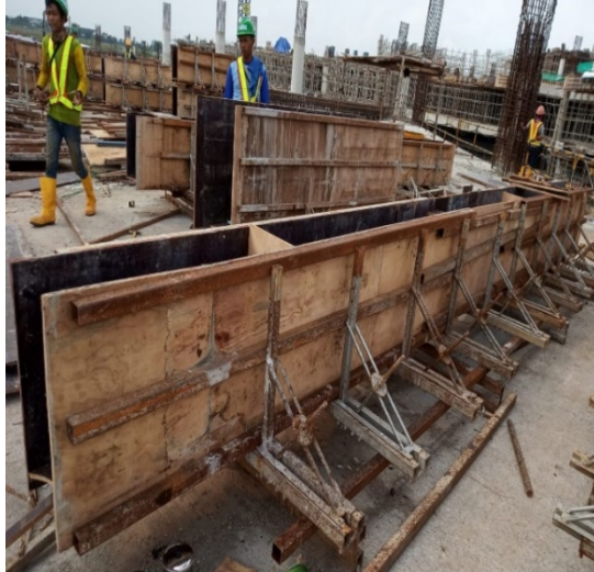
Gambar 1 Bekisting Konvensional
