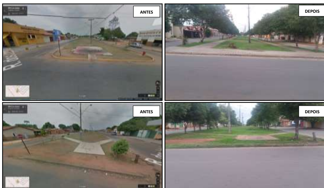
Imagem 2 - Cruzamento entre Avenida Guaíba e Rua Jatobá – antes e depois
