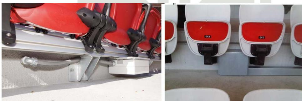
Gambar 2.7. Pemasangan AP dengan metoda *floor coverage* pada suatu *convention Centre*
