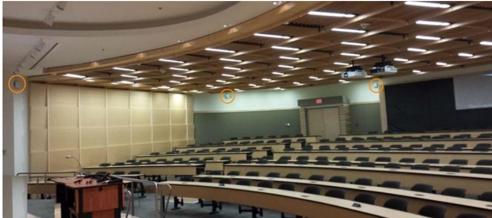
Gambar 2.6. Pemasangan AP dengan metoda *side coverage* pada suatu *convention Centre*
