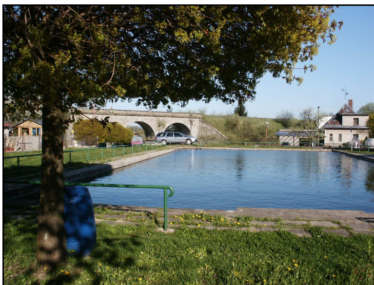
Obr. 15: Požární nádrž v bílé Třemešné (foto: archiv autora)
