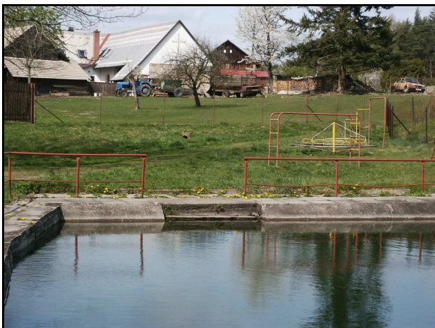
Obr. 14: Požární nádrž v obci Zdobín (foto: archív autora)
