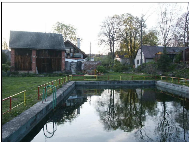
Obr. 18: Požární nádrž v obci Trotina (foto: archiv autora)
