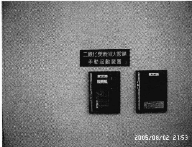
· 귀중본실 서고 입구에 이산화탄소 소화기 설치
