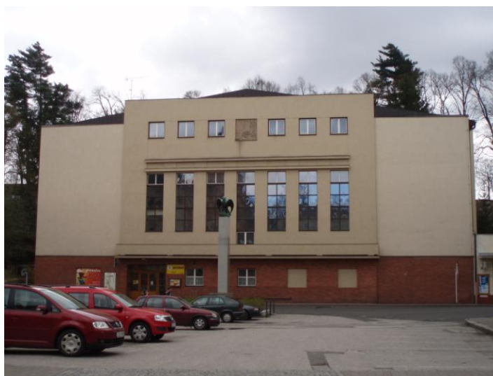
Obr. 2: Budova sokolovny v Jilemnici ( Zdroj: vlastní )
