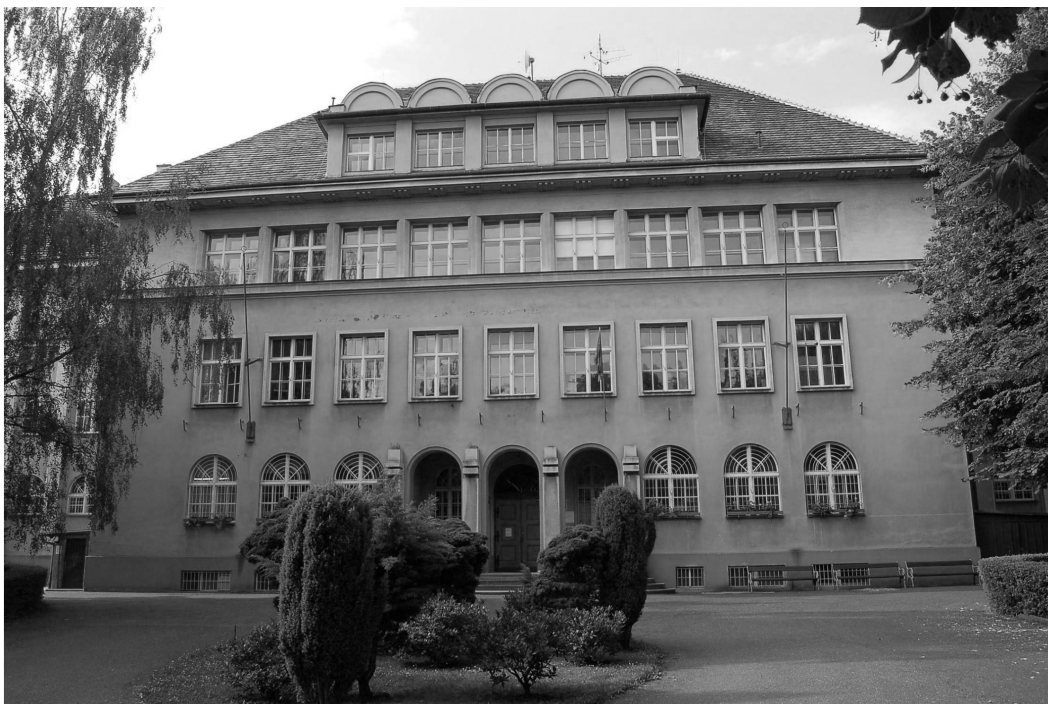
Obrázek 4: Budova OA Žatec
