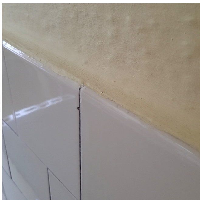
Obr. 75: Ukončení obkladu pomocí původních zaoblených obkládaček, Zdroj: vlastní
