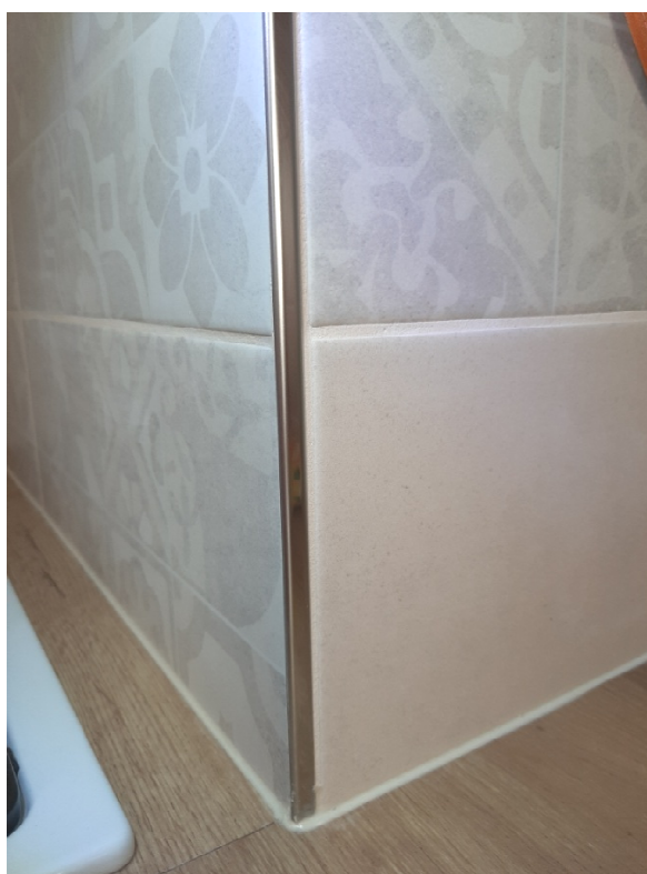
Obr. 77: Napojení obkládaček v nároží pomocí nerezové lištičky, Zdroj: vlastní
