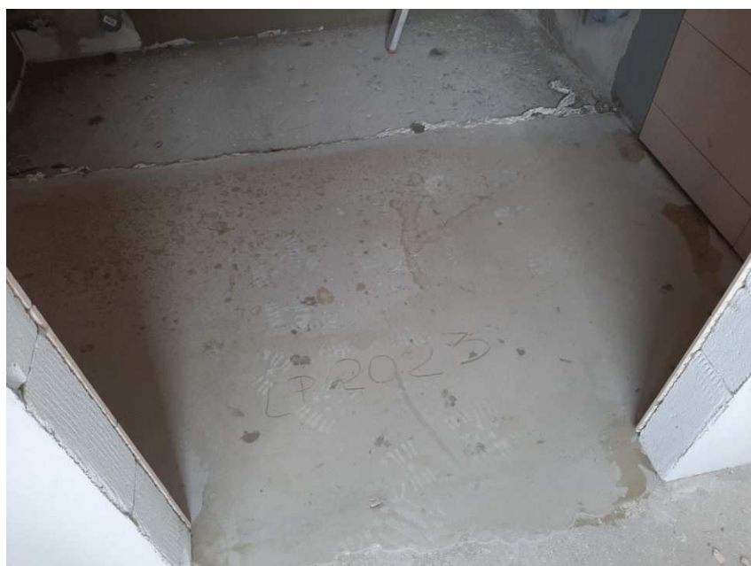
Obr. 70: Část podlahy koupelny po vyrovnání nivelační stěrkou
