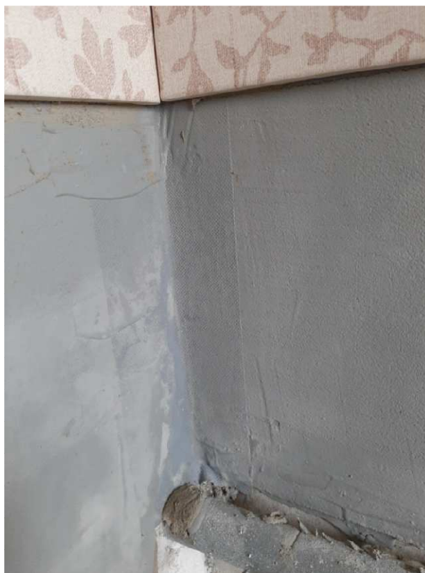
Obr. 71: Aplikovaný těsnící pásek CL 252 v koutu stěn
