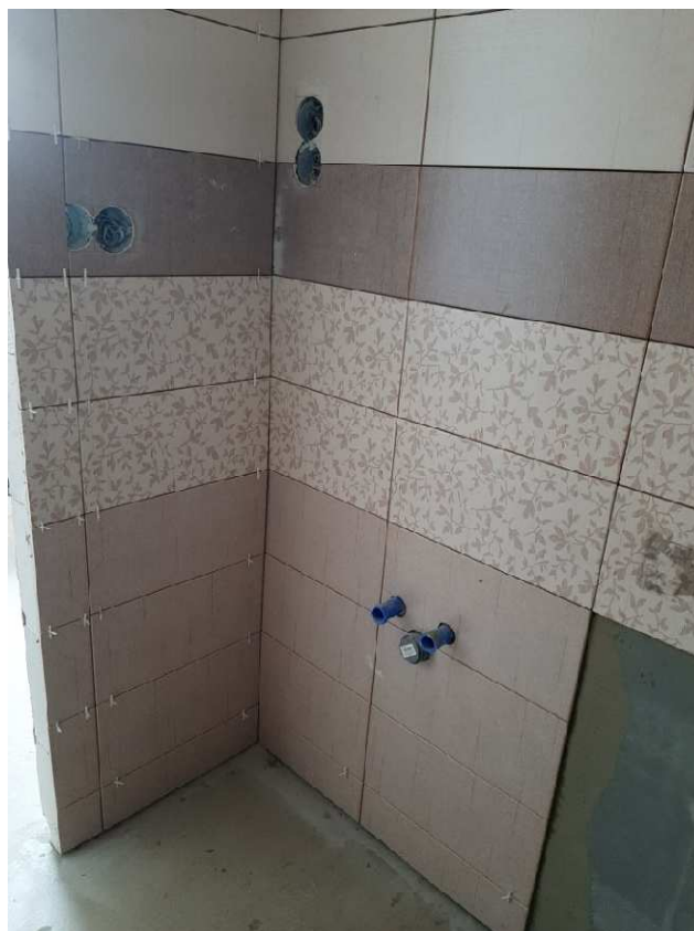
Obr. 72: Stěna koupelny v průběhu obkládání - viditelné vymežovací křížky
