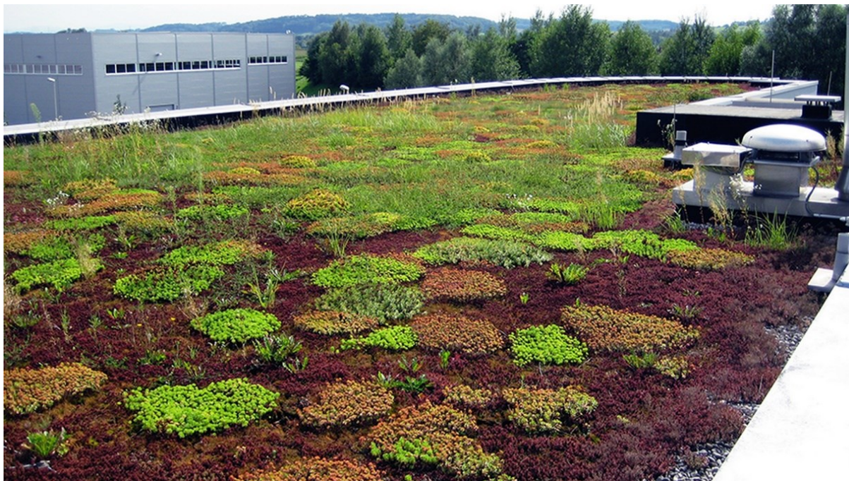
Obr. 7 Příklad zelené střechy
