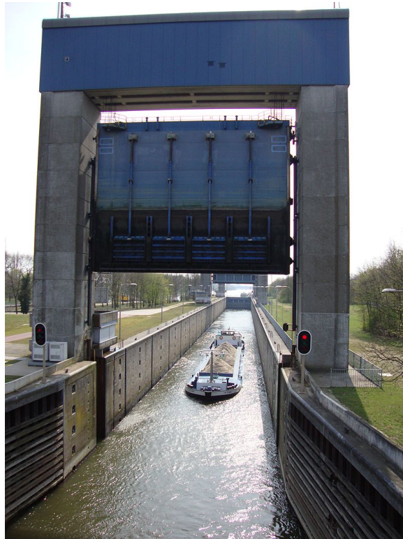
Figure 3.5: Guillotine gate [28]
