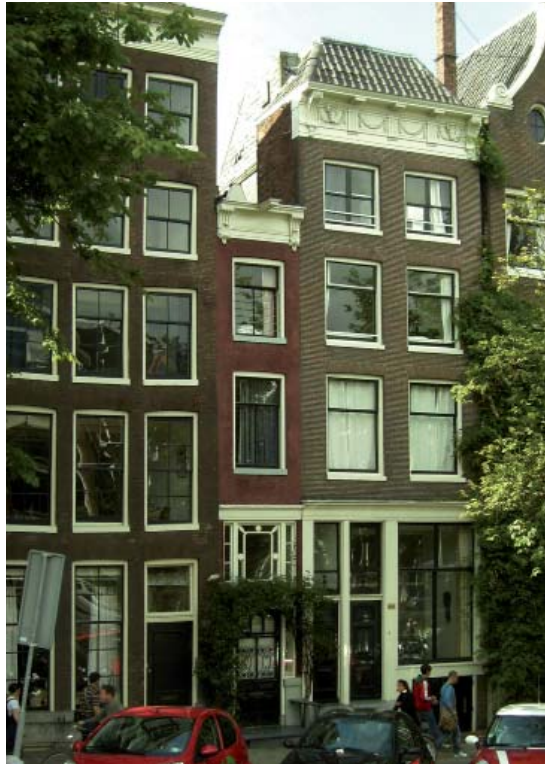
Figuur 5.13 De afmetingen van dit Amsterdamse grachtenpand heeft grote beperking voor de invulling van de ruimte.
