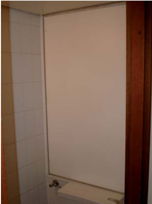
Figuur 5.6 De plaat in het toilet is eenvoudig te verwijderen waardoor de leidingschacht is te bereiken. Een voorbeeld van toegankelijkheid en obstructie.
