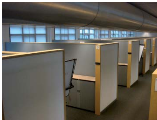
Figuur 2.2 Verplaatsbare wanden verhogen de indelingsflexibiliteit. Een methode die vaak in kantoren wordt toegepast.
