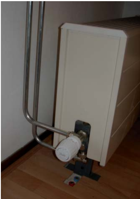
Figuur 2.1 Door lekkage was het nodig een nieuw waterdistributienetwerk aan te leggen. Het oude netwerk kon niet verwijderd worden.
