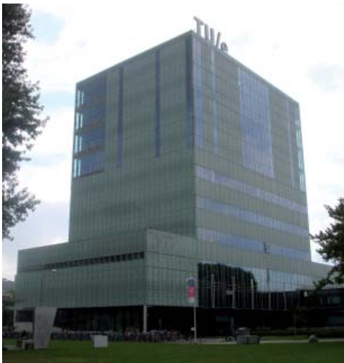
Figuur 5.8 De gevel van het bouwkunde gebouw van de TU/e is volledig vervangen.
