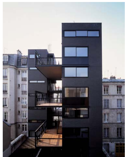
Figuur 3.4 Het gebouw aan de Rue de l'Ourcq bestaat uit twee bouwblokken verbonden door een galerij.
