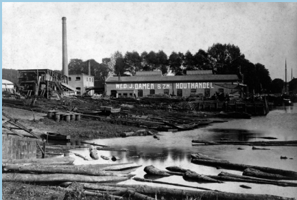
Figure 50. Wood factory (Photograph: erfgoedshertogenbosch.nl)
