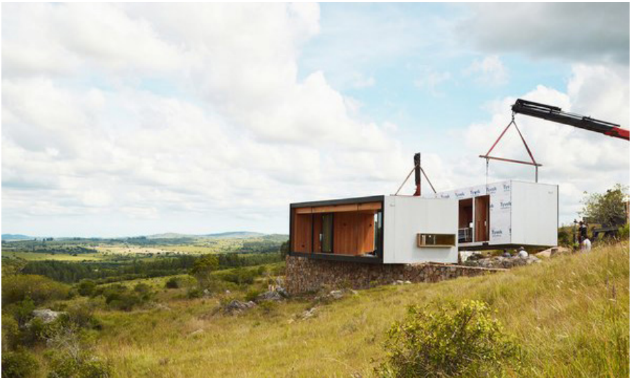
Fig. 3.1.1.3 Placing of module [Finotti, L., n.d.]
