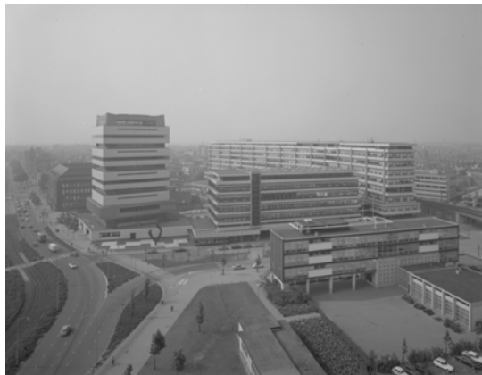
Afb. 2.7 Scholencomplex Technikon en Akragon, 1973
