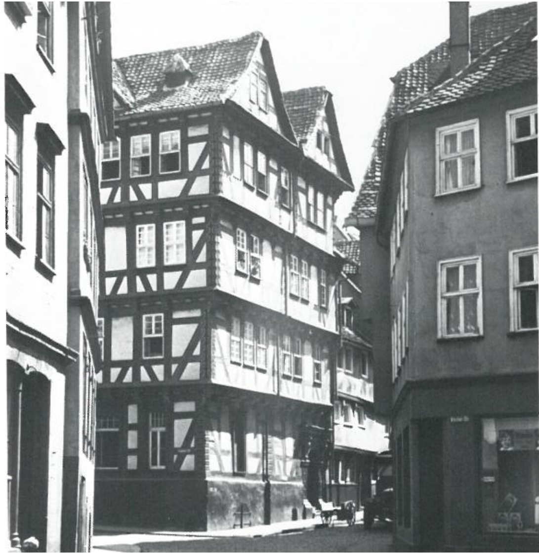
Fig. 27 Old Kassel Fachwerkhaus Klosterstraße
