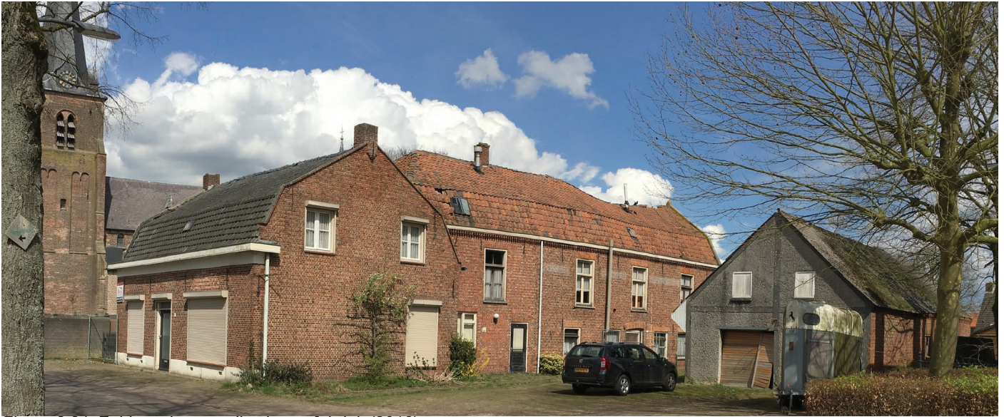
Figuur 3.21. Zuidgevel voormalig sigarenfabriek (2016)
