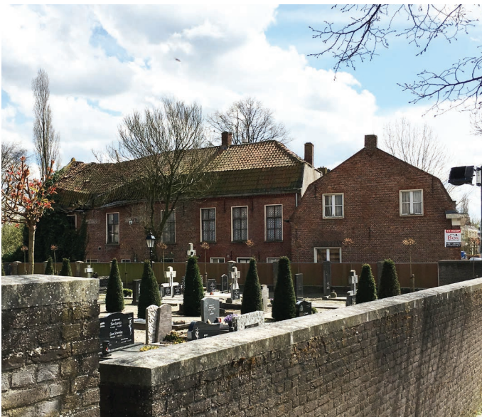
Figuur 3.22. Noordgevel voormalig sigarenfabriek (2016)
