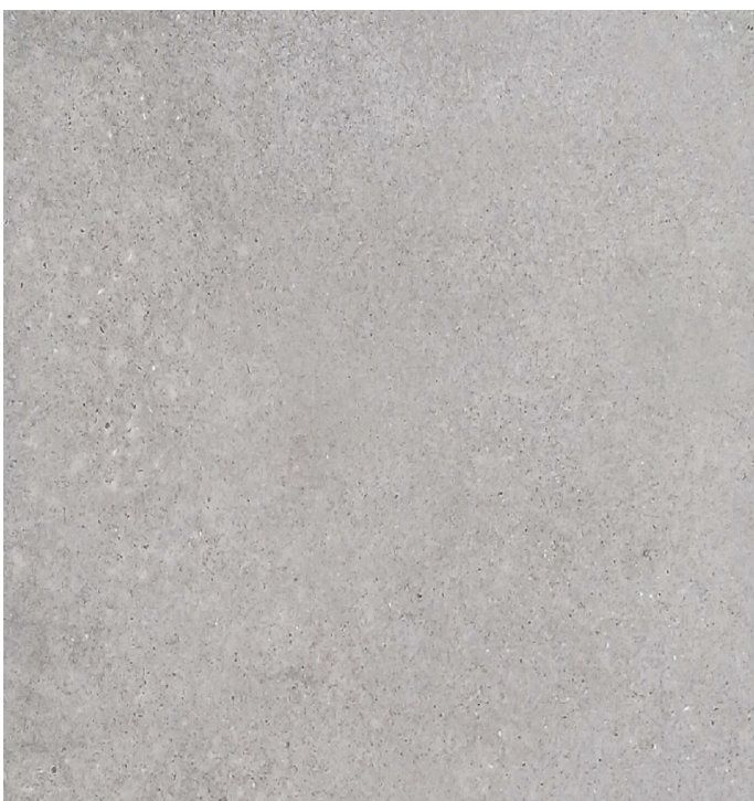
65 Gepolijste betonnen vloer in de galerijen
