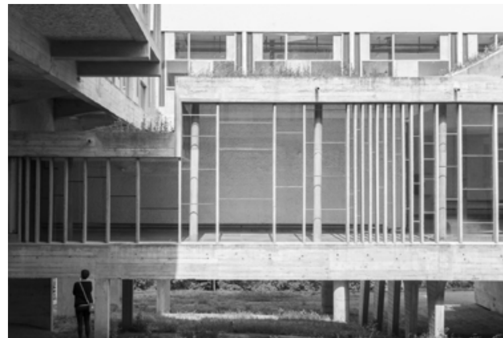
Een van de loopgangen, losgekoppeld van de grond
