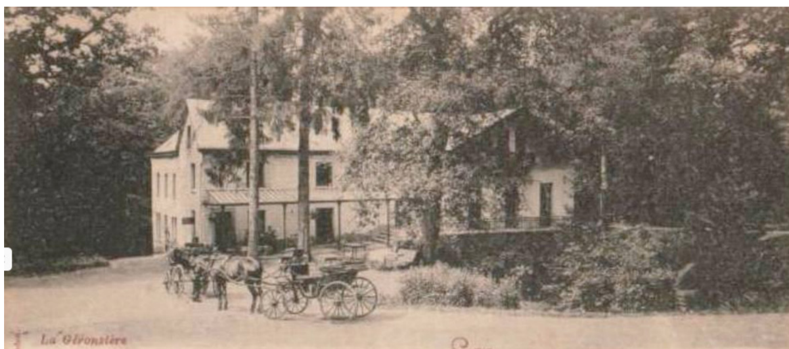
[29] Foto huidige brongebouw voor renovatie
