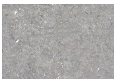
belgisch hardsteen buitengevel
