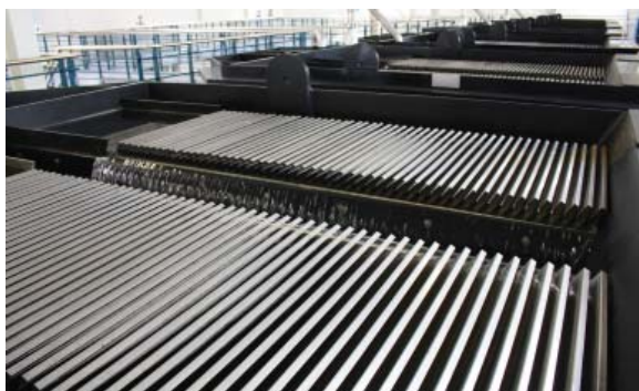
Lamellae separators (plant in Andijk)
