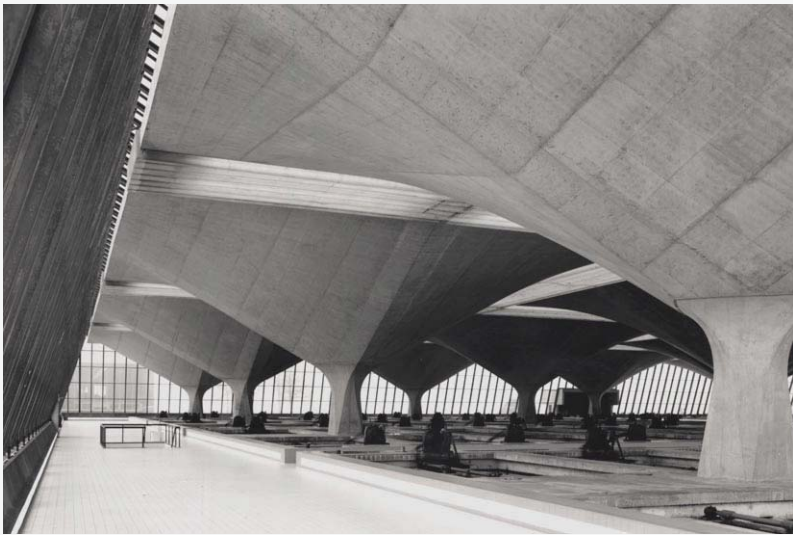
Filtergebouw Berenplaat, Wim Quist
