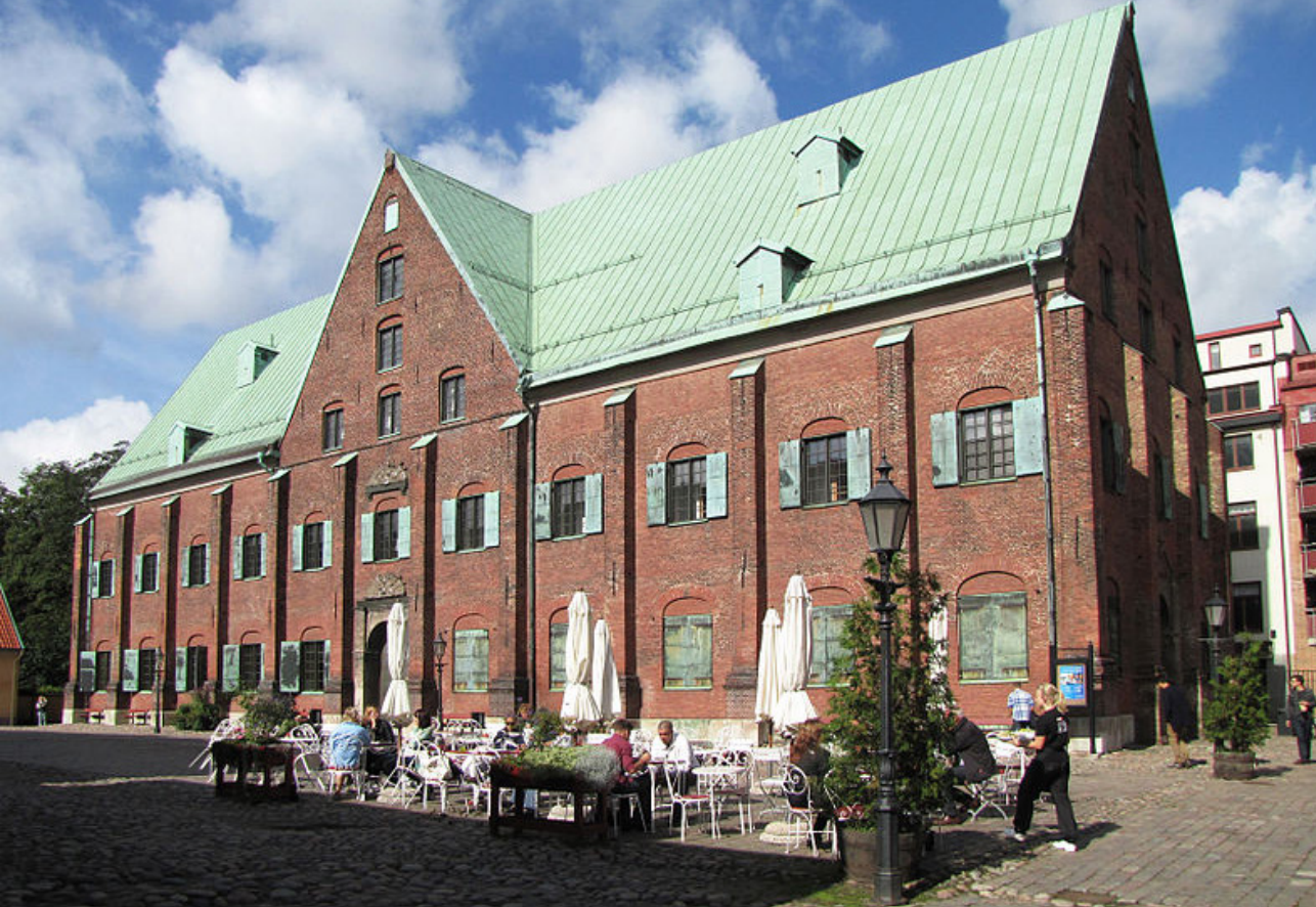
Afbeelding 10: Kronhuset met zijn langerekte bakstenen gevel.
