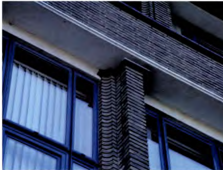
24 - Gevelafwerking rond de gevelopeningen van de hoofdvleugel
