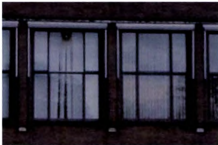
49 - Huidige buitenzonwering als vervanging van het oorspronkelijke systeem
