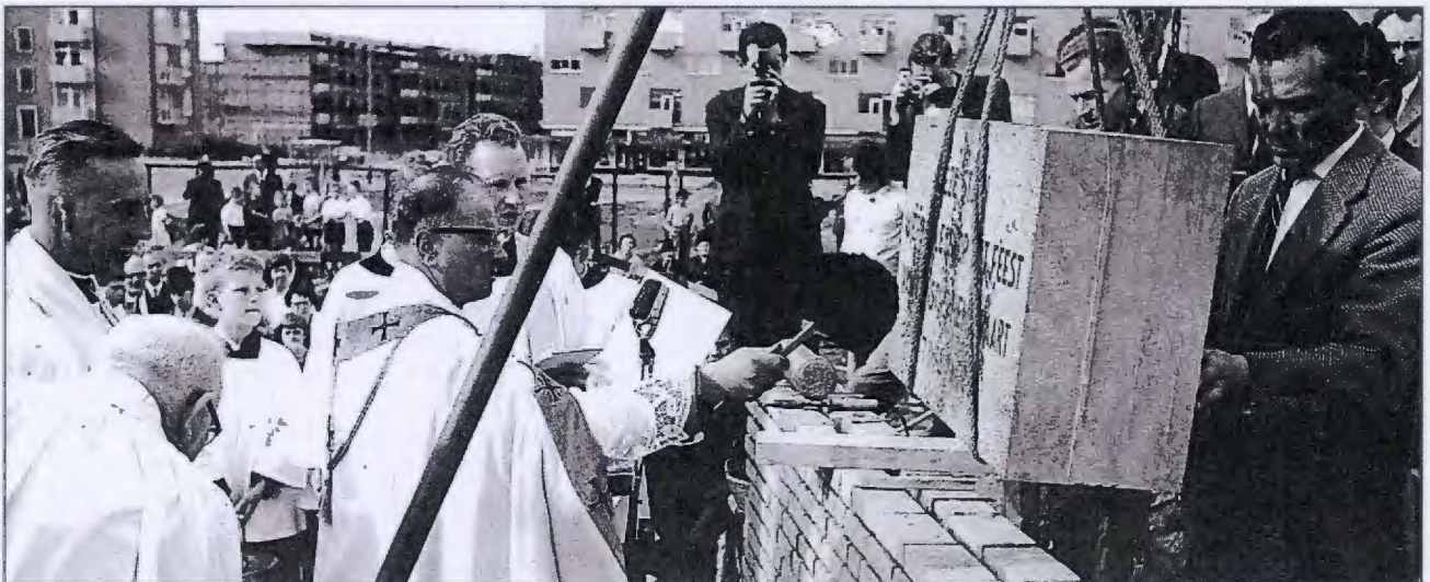
Figuur 19. Kerk Pottenberg in aanbouw [bron: Fotoarchief RHCL]
