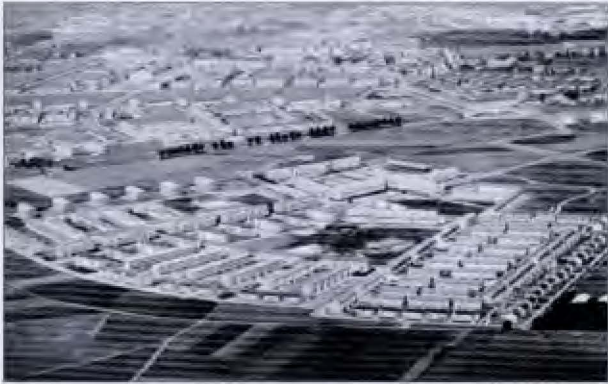
Figuur 24. Vogelvlicht Pottenberg in aanbouw [bron:Venne 1964]
