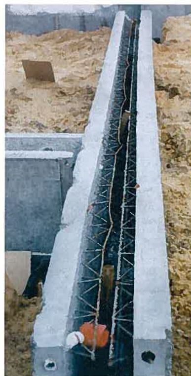
Figuur 1: betonnen bekistingselementen
