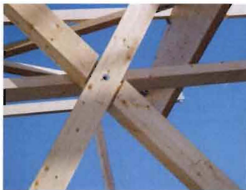
Figuur 0.2 Houten windverband
