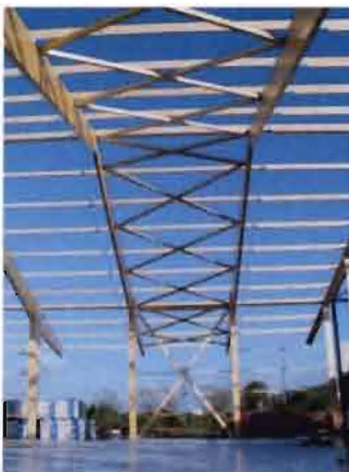
Figuur 0.1 Winverbanden in dak en gevelvlakken
