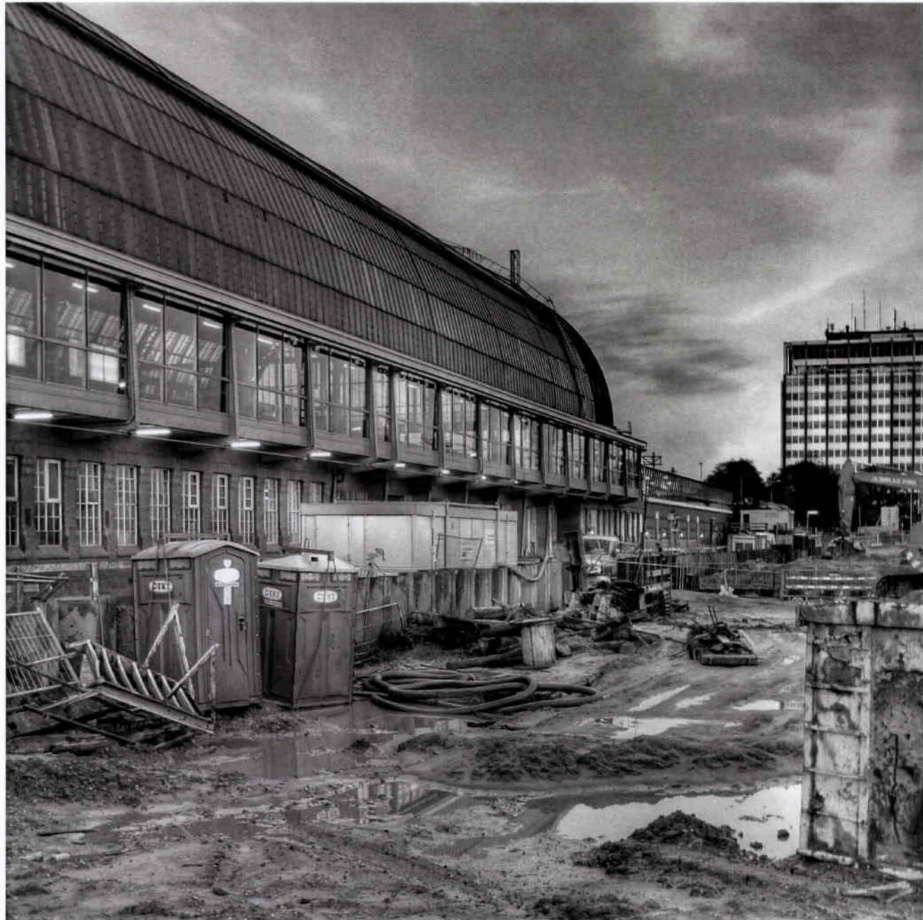
AFBEELDING 4.01 Bouwterrein Amsterdam CS
