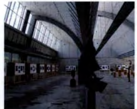
afbeelding 6.20 Goede conditie van dak, wanden, constructie en vloer; De Ploeg, Bergeijk, 2006.
