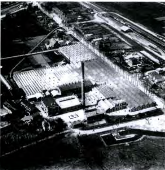
afbeelding 6.4 Ontwikkeling van een fabriekcomplex, terrein linksachter wordt tussen 1924 en 1930 bebouwd; Ten Cate, Nijverdal, 1922. (bron: Bierman Henket architecten)
