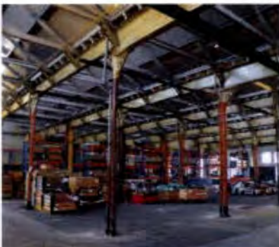
afbeelding 6.18 Goede conditie van dak, wanden, constructie en vloer; NS-werkplaats, Tilburg, 2008.
