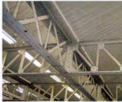
afbeelding 6.13 Staalconstructie in goede conditie; Ten Cate, Nijverdal, 2006. (bron: Bierman Henket architecten)
