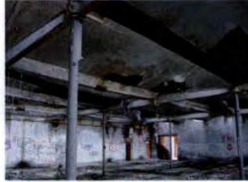
afbeelding 6.10 Laslatende plafondafwerking; Stoomweverij, Aalten, 2008.
