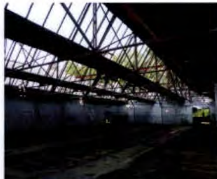
afbeelding 6.19 Slechte conditie van dak, wanden, constructie en vloer; Stoomweverij, Aalten, 2009.
