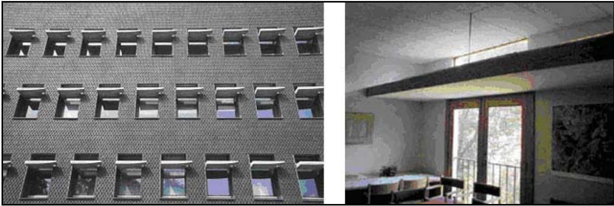
Fig. 51b. Lichtplanken in de gevel van een kantoor (Kantongerecht, Amersfoort, 1999). De lichtplank bevindt zich ook aan de binnenkant, met als doel om via weerkaatsing door reflectie het daglicht zo diep mogelijk in de ruimte krijgen. Een lichtplank aan de buitenzijde is effectiever. Een lichte afwerking van het plafond is hiervoor noodzakelijk.
