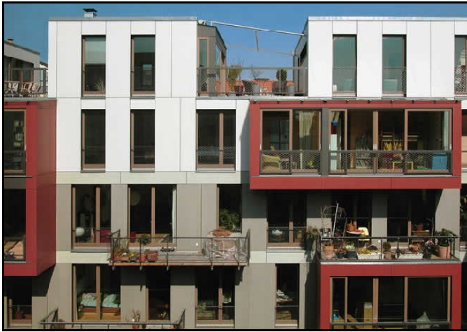
Fig. 30c. Het appartementencomplex met verschillende gevelkleuren, -dieptes en -functies diende als voorbeeld (Stuttgart, 2001).
