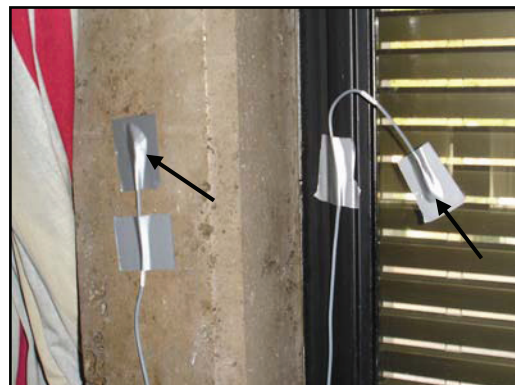
Figuur 18 Afbeelding van een oppervlakte temperatuursensor (links) en de toepassing ervan (rechts). De sensor wordt vaak met behulp van ducttape tegen het oppervlak aangebracht. In dit voorbeeld is een sensor aan de binnenzijde van een buitenwand en op het glasoppervlak aangebracht.
