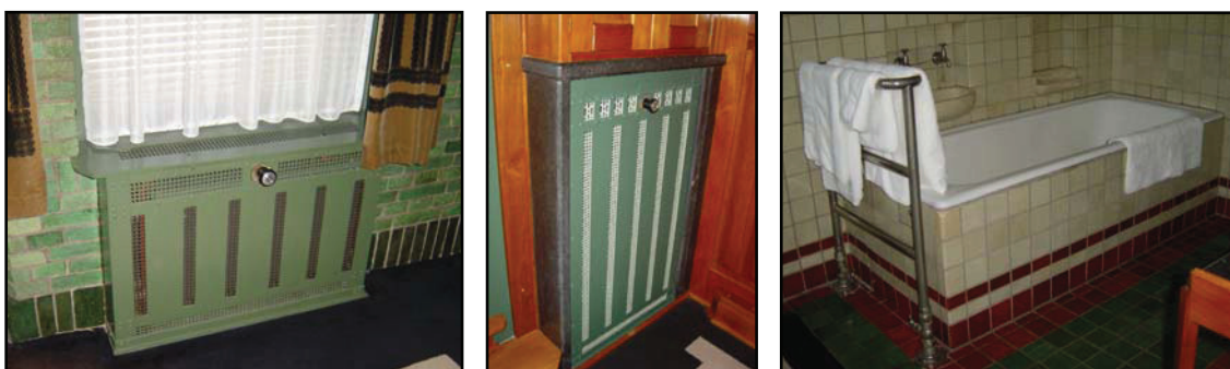
Figuur 41 De radiatoren in het jachthuis zijn grotendeels weggewerkt achter een originele omkasting. De badkamers zijn voorzien van originele handdoekradiatoren.
