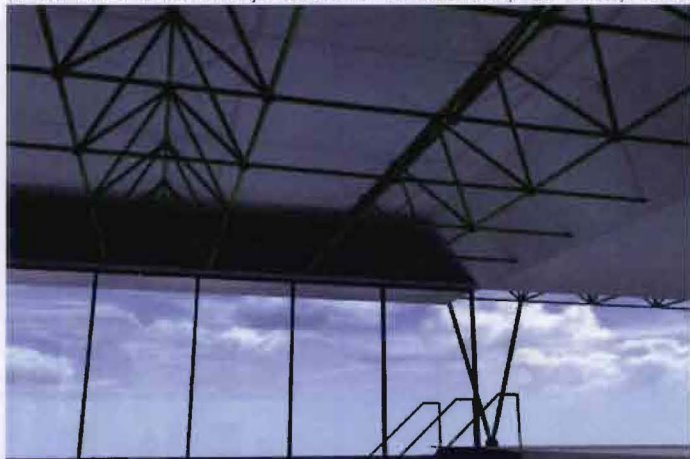
75 van binnen is het ruimtelijk vakwerk optimaal te ervaren
