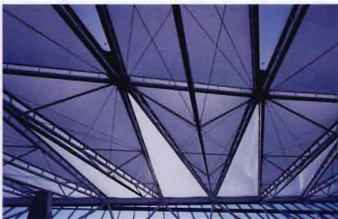
30 Dakconstructie Villa Arena Amsterdam
