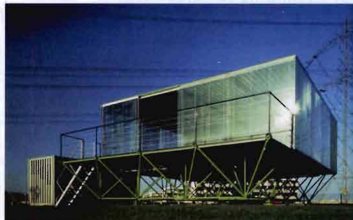
24 woonhuis Benthem, zelfde tijd, zelfde vakwerkconstructie als Hazeldonk
