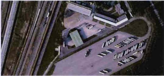
13 geparkeerde trucks vormen volumes op het verder lege parkeerterrein
