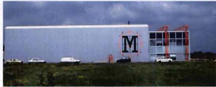
26 Tweedeling in werkzaamheden en uitstraling in bedrijfsgebouw MORS
