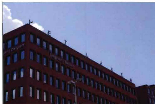
Figuur 5.45 gebouw het laken aan de Hart van Brabantlaan (overzijde locatie Hart van Brabant) (bron: auteur)
